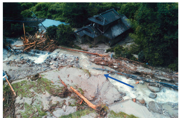
写真－3 令和元年災害 土石流被害状況
