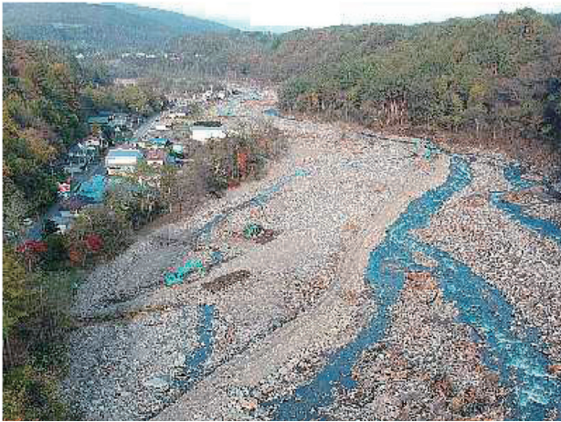
写真－5 長井川原集落の瀬替え状況
