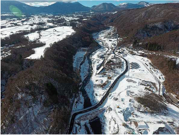
写真-7 国による緊急迂回路 (落橋した鳴岩橋の代替道路)
