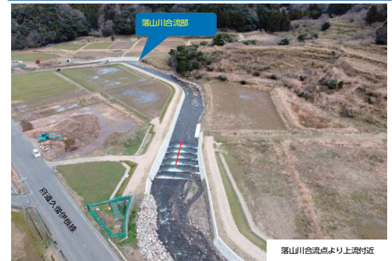
落山川合流点より上流付近
