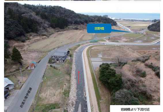
岩崎橋より下流付近
