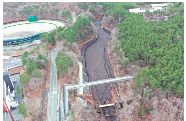
写真-12 宮川堰堤工の土砂捕捉
