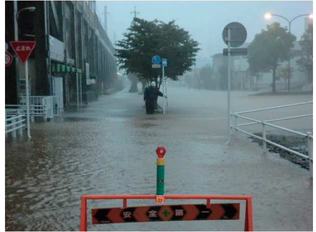
写真-4 鈴鹿駅付近（平成24年台風第17号）
