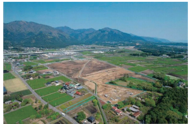
写真－2 民間主導型の工業団地造成
