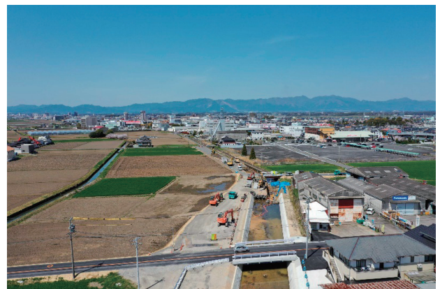
写真－5 金沢雨水幹線整備事業
