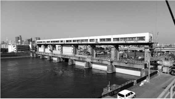
水門閉鎖中（旧江戸川・新中川 今井水門） （江戸川区地内）
