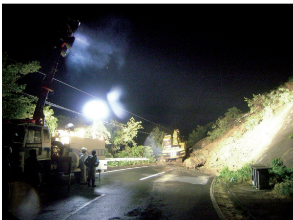
写真-2 5月31日未明の作業状況
