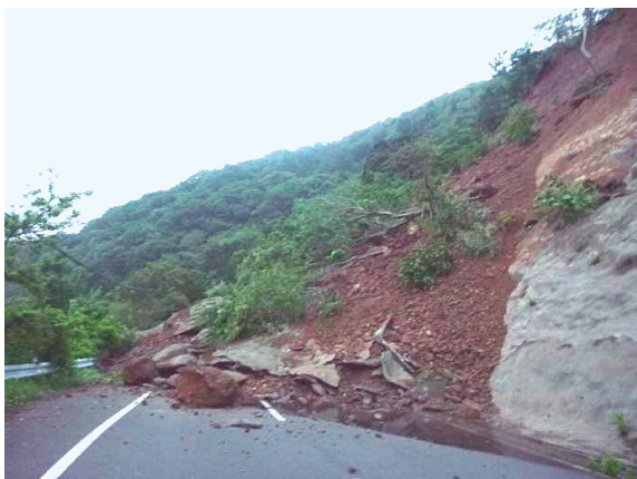
写真-1 5月30日崩壊状況
