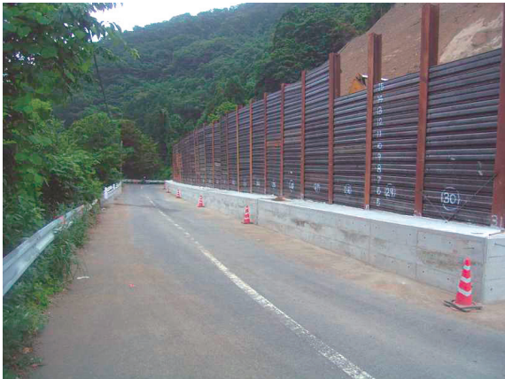
写真-6 7月4日仮設防護柵補強
