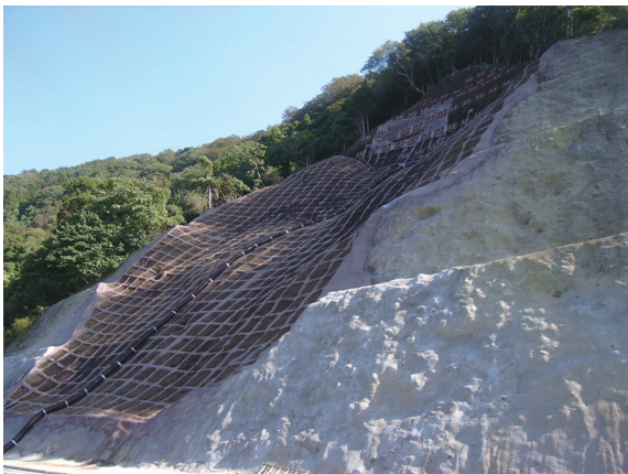
写真-7 工事完成
