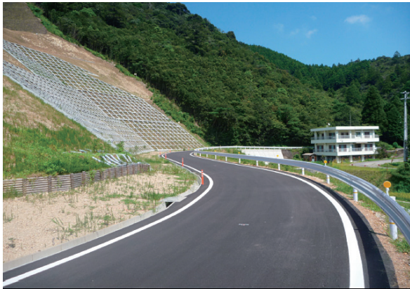
完成写真① (起点側より望む)
