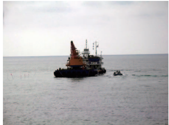
写真-4 海上作業の様子
