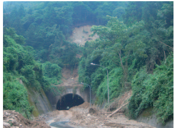
写真一 2 国道315号 (金山谷トンネル)
