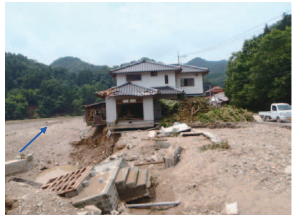
写真一9 二級河川田万川（護岸崩壊）
