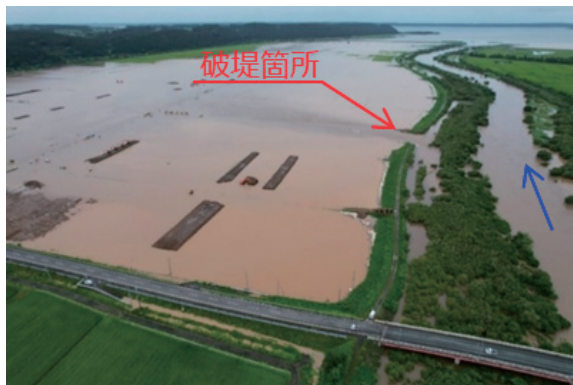
写真－4 高瀬川堤防決壊箇所（七戸町川口）
