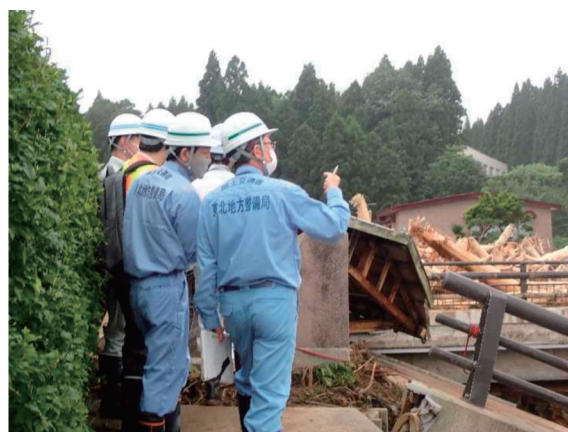
写真－6 TEC-FORCE による小赤川橋の被災調査状況
