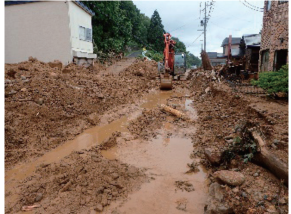
写真-11 国道279号道路啓開作業 (風間浦村下風呂)
