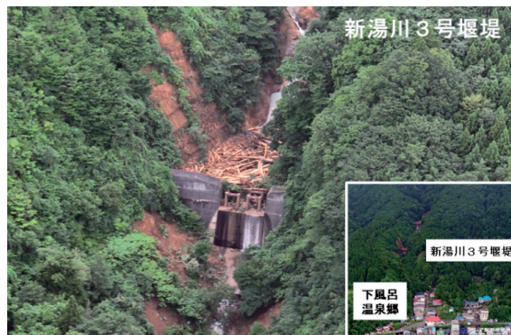
写真-16 流木を補足した砂防堰堤と 歴史ある名湯下風呂温泉郷
