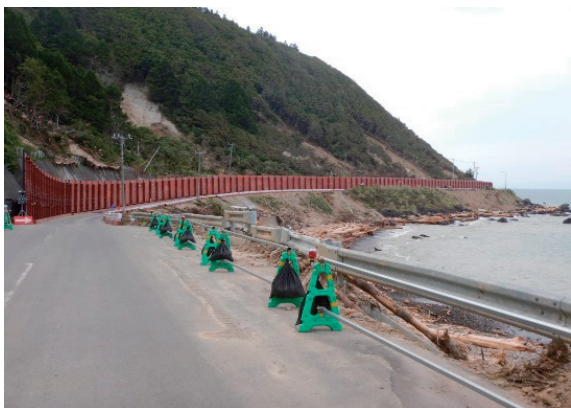
写真-14 国道279号仮設防護柵設置完了 (風間浦村下風呂)
