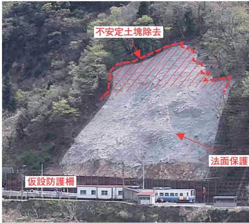
写真-3 応急対策完了
