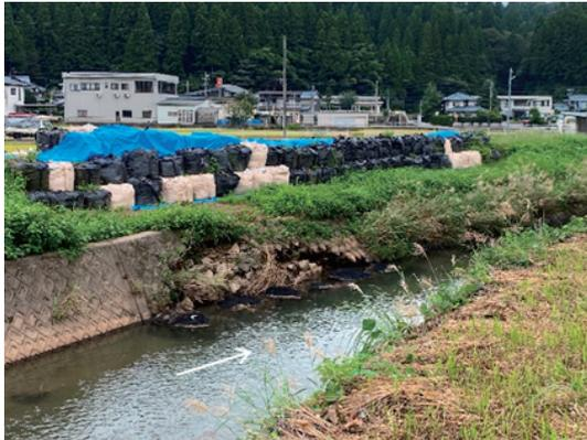
写真-5 破堤箇所の応急対策完了
