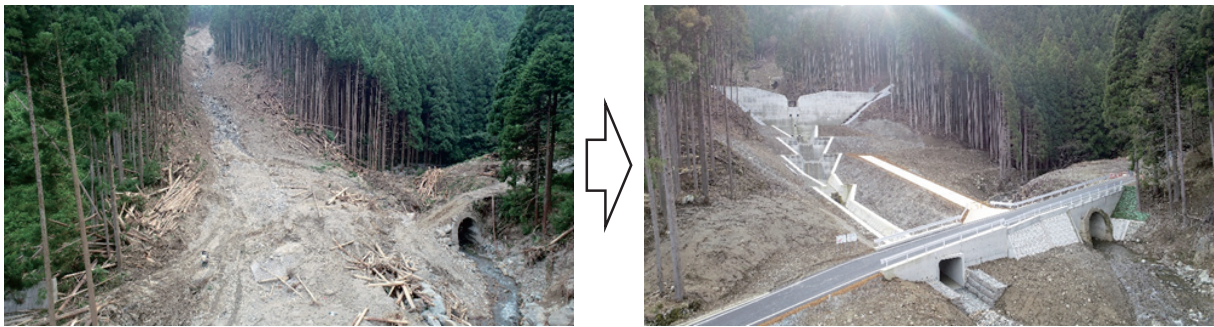
写真-5 上流堰堤と国道の復旧状況
