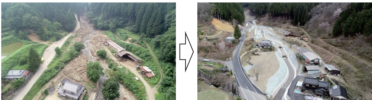
写真-7 溪流保全工の復旧状況
