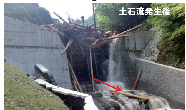
写真-1 堰堤の土砂・流木の捕捉状況
