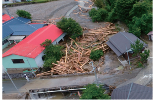
写真-3 下流域に流出した土砂・流木
