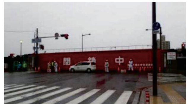
図-8 国道2号の防潮鉄扉（神崎川：神崎大橋左岸）
