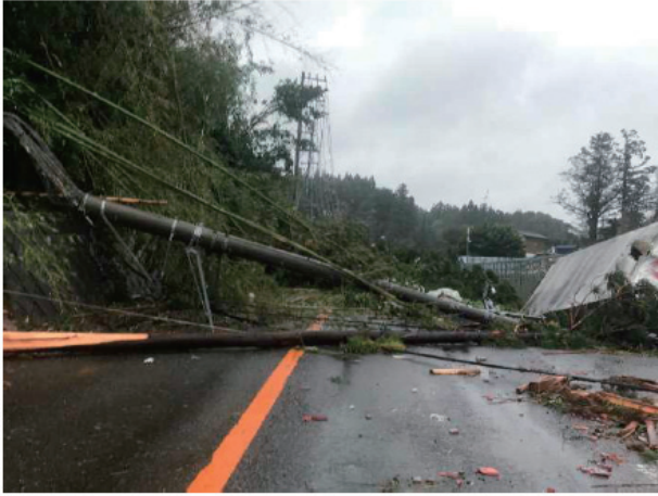
強風による倒木被害・電柱倒壊状況
