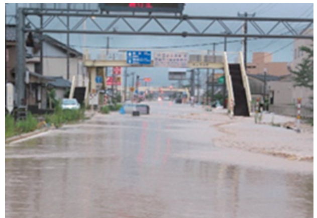
写真-1 国道 7 号浸水状況
