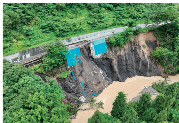
写真-4 一般国道121号（米沢市）
