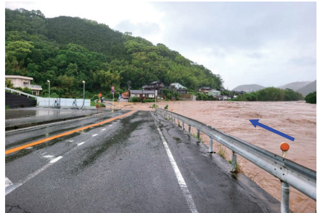
写真－4 5年災 貴志川の越水状況 (越水により道路が冠水した)
