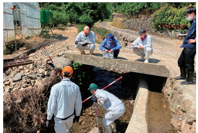
写真－5 前査定実施状況 (広川町)
