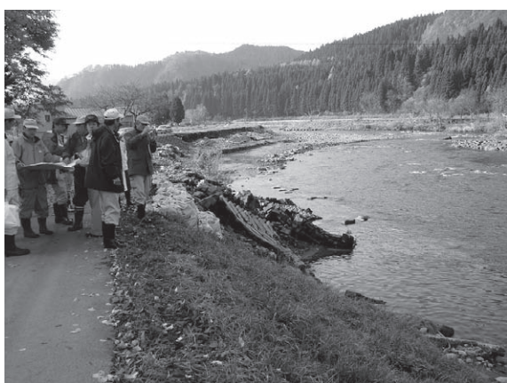
写真一4 災害査定・現地調査 (平成19年11月12日～16日)
