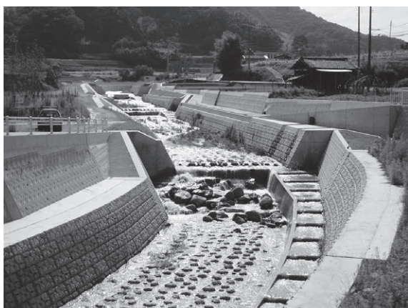
直落差工 (水叩き部に現地石を設置・みお筋には魚道) (BCブロック)
