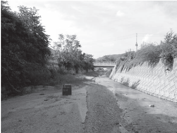
着工前 (Aブロック)
