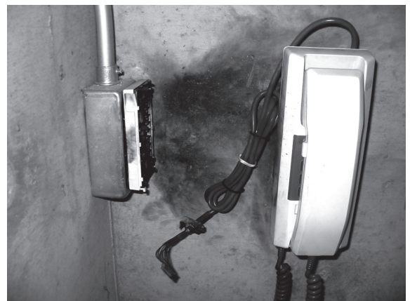
送受信所内インターフォンの焼損状況
