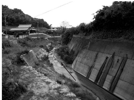
着工前 (Dブロック)
