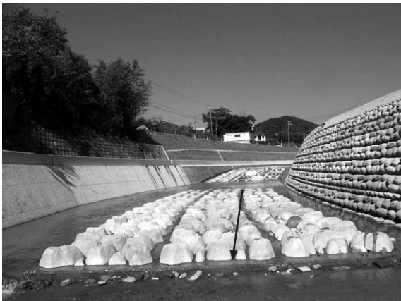
工事完了後 (Aブロック)
