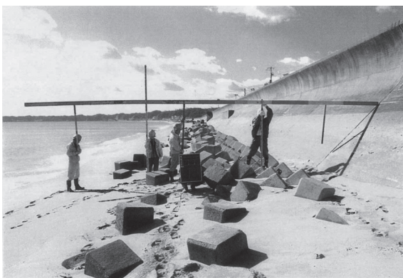
消波工の沈下状況
