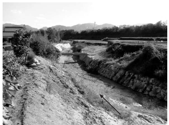
着工前(田畑が土石流によりえぐりとられているのが確認できる)(BCブロック)
