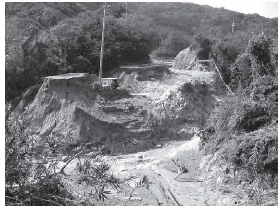
被災後の県道鳥飼浦洲本線・大財上池
