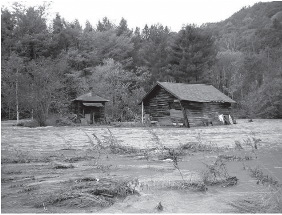
溢れた川の水で浸水した倉庫
