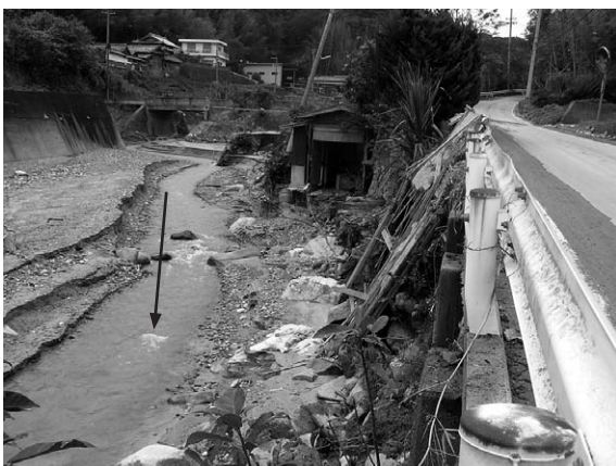
上流部被災状況 家屋流失
