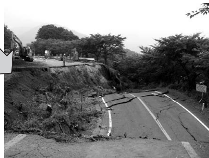
【7月26日 12時 道路の陥没さらに拡大】
