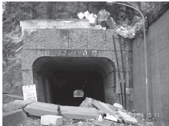
写真-1 被災した八世乃洞門
