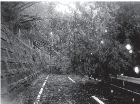
写真-3 倒木により塞がれた道路
