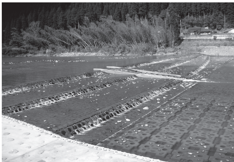
写真-6 完成写真
