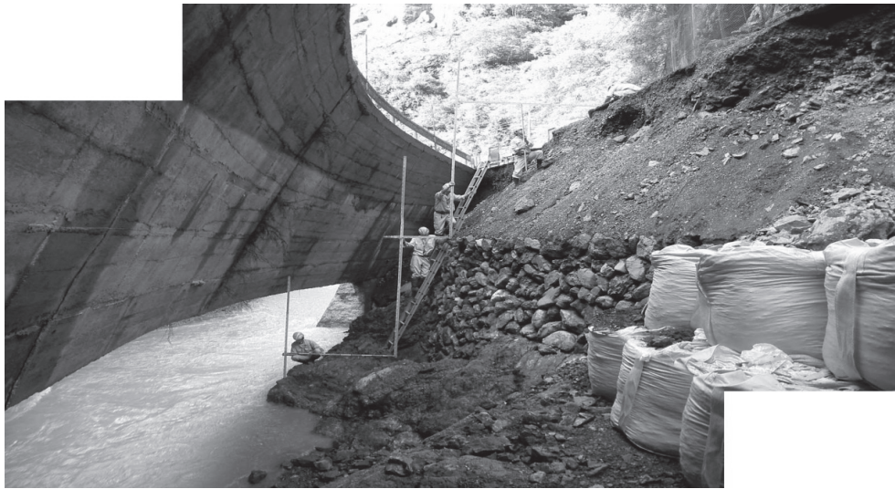
写真-6 崩落した道路内部の様子
