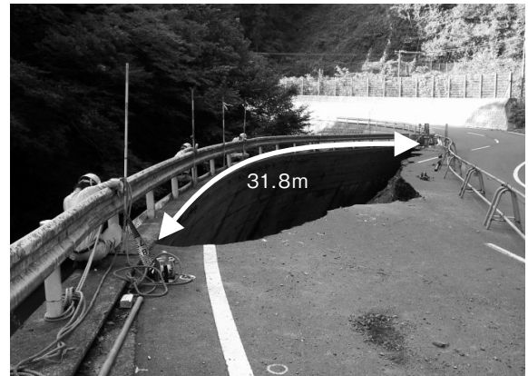
写真-4 崩落した路肩
