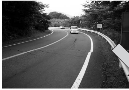
【7月23日 9時 道路上にクラック発生】
