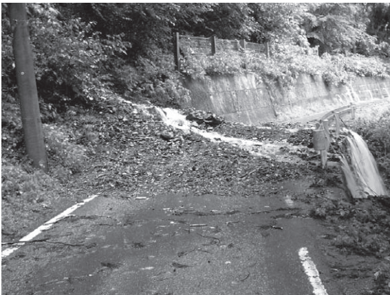
写真-2 道路に流出した土砂
