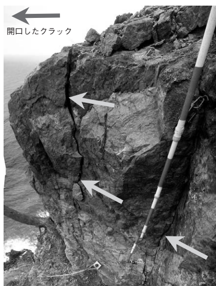
写真-4 崩壊岩塊側面部
