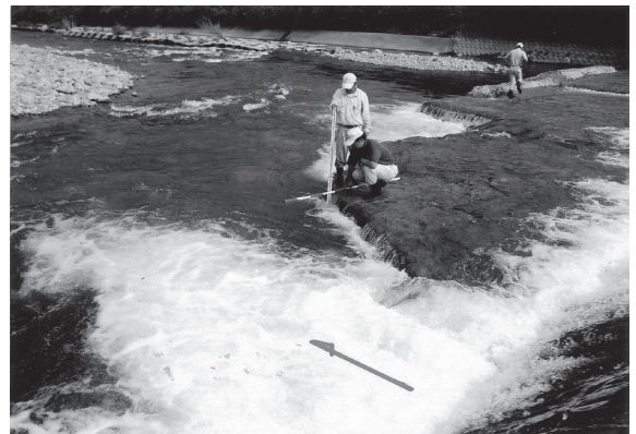
写真-1 水叩き部の流失
