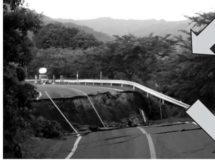
【7月25日 6時 道路の陥没拡大】
