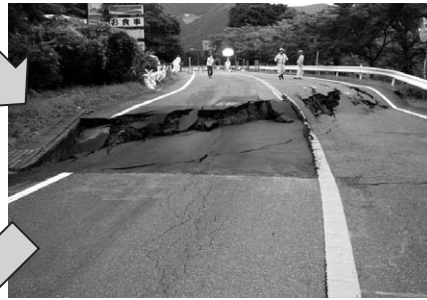
【7月24日 6時 道路の陥没状況】
