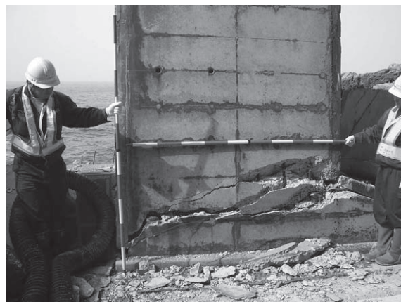
写真-2 海側コンクリート側壁被災状況
