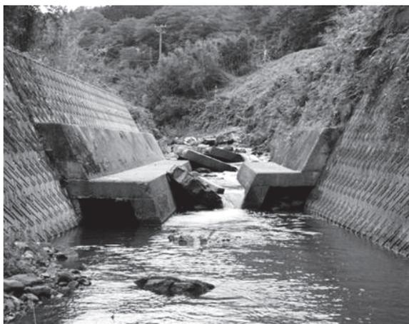
根継ぎ工で復旧した箇所が再度被災した事例
