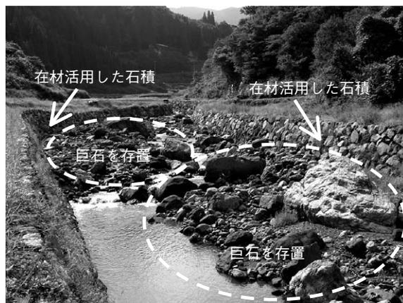
在材活用した石積護岸で復旧するとともに、異常堆積土砂の撤去において巨石を上手に残し、環境景観および親水機能を復旧した事例
