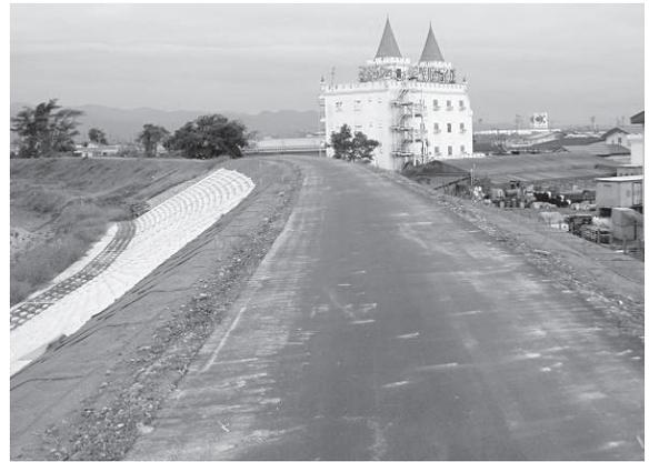
一級河川刈谷田川：堤防亀裂（液状化対策を実施して復旧）
