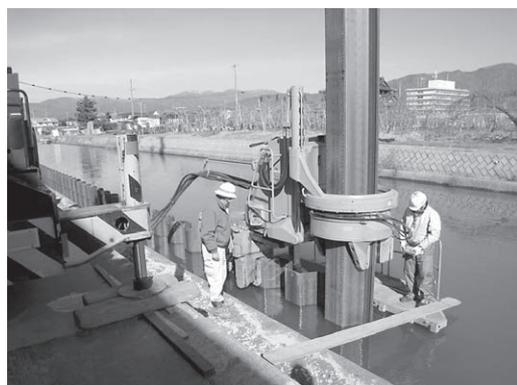
【助成・舟渡川】サイレントパイラーによる鋼矢板の打ち込み
