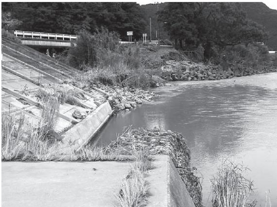
着工前（下流区間）護岸基礎の根が洗われている
