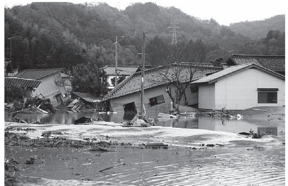
堤防決壊により水流に押しつぶされた家屋
