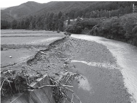
被災直後(上流区間)護岸が壊れ、水田が流出している
