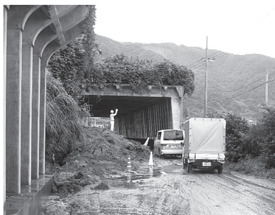
写真-6 国道269号南大隅町大川の片側通行
