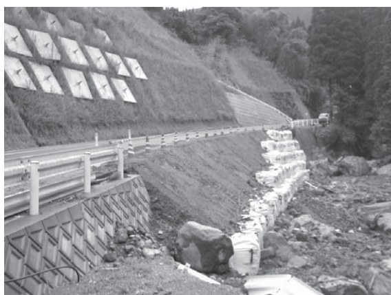
同上応急復旧状況
