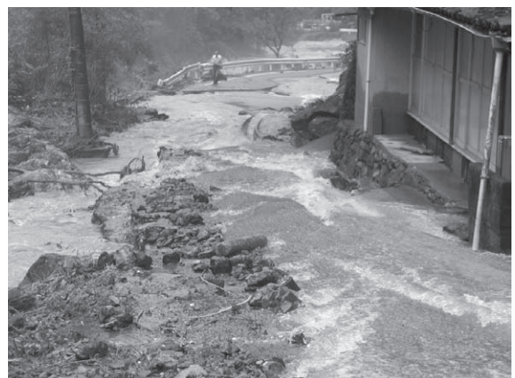
国道445号被災状況
