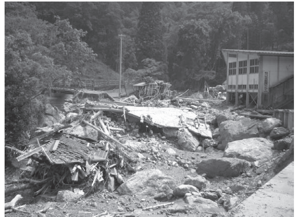
一級河川緑川水系柏川（上流）被災状況
