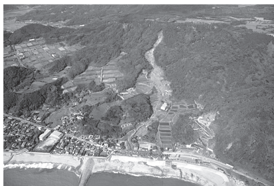
写真-4 南大隅町大浜土石流災害
