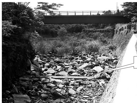
写真－2 被災前の状況
