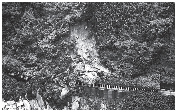
写真－7 国道269号南大隅町伊座敷の崩壊
