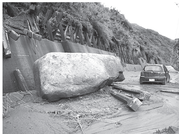
写真－2 国道269号南大隅町浮津の落石
