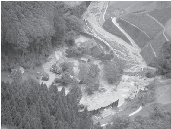
住宅孤立状況（椿地区）
