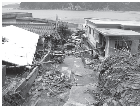
写真－1 南大隅町浜尻集落の被災状況
