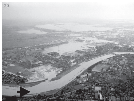
諏訪地区（左岸） 破堤状況（H16.7.14）
