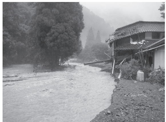
一級河川緑川水系柏川（中流）被災状況
