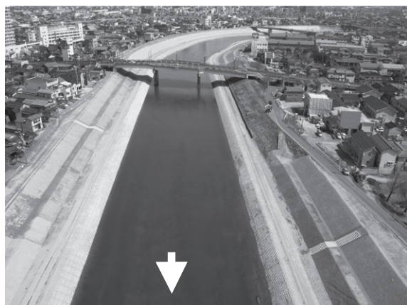
本町（右岸）～北新保（左岸）の河道工事 完成状況（H20. 3 月）
