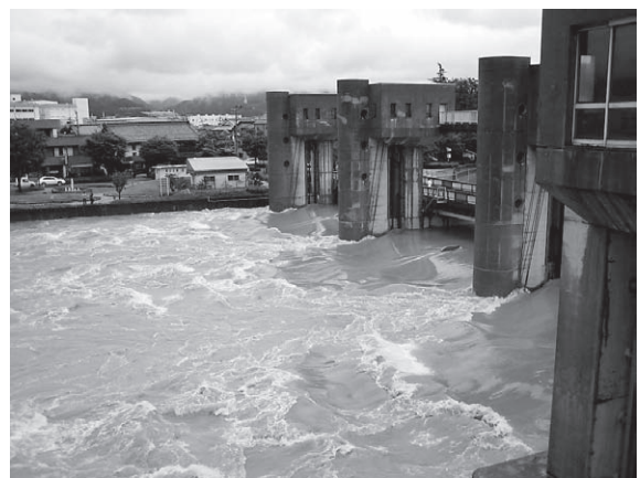
写真－1 400m 3 /s 放流時の釜口水門
