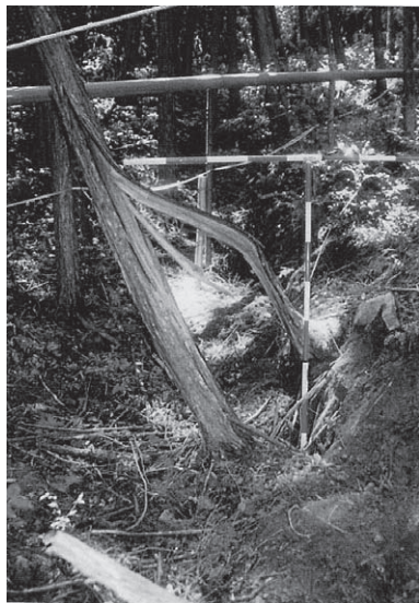
写真-3 樹木の異常植生 (地すべり活動により引き裂かれた樹木)
