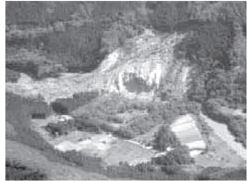
迫川小川原地区の山の崩壊状況
