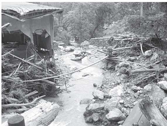
土石流被害状況（柏川集会所）
