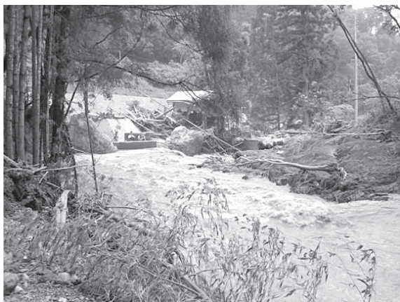
土石流堆積状況（柏川キャンプ場）
