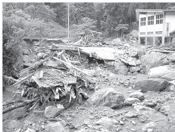
土石流被害状況（社会教育センター）
