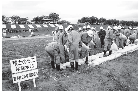
高校生による体験水防 (北上川上流水防演習)
