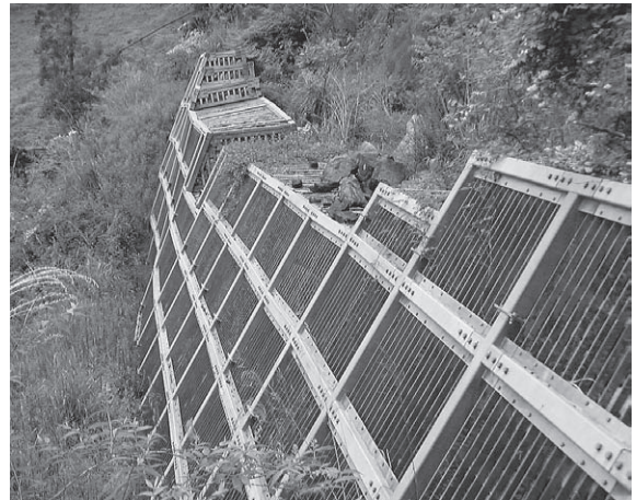
写真-4 鋼製堰堤被災状況
