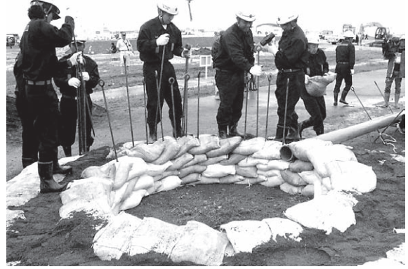
釜段工 (吉野川・那賀川合同水防演習)
