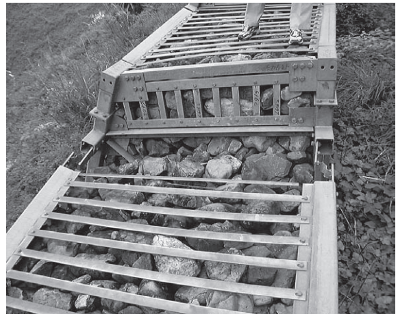
写真-5 鋼製堰堤被災状況
