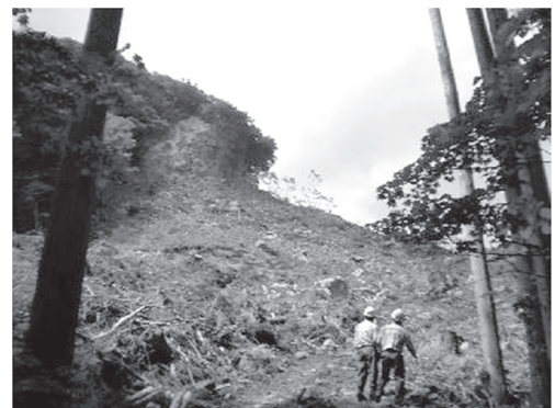
土砂災害危険箇所調査状況（6/17）
