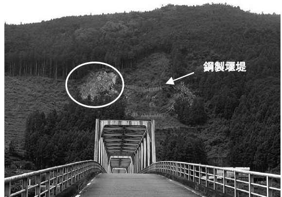
写真-1 末端部表面崩壊状況
