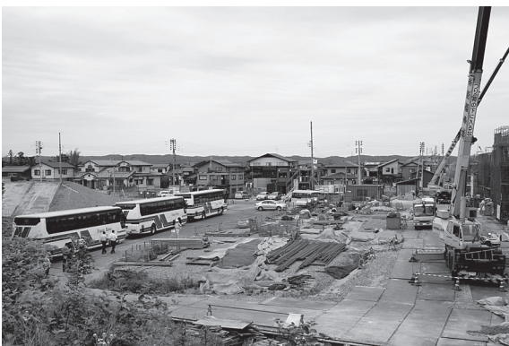
現地視察（刈谷田川災害復旧助成事業：現地状況）
