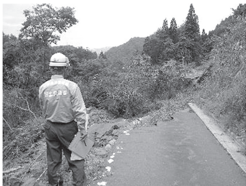
土砂災害危険箇所調査状況（6/17）
