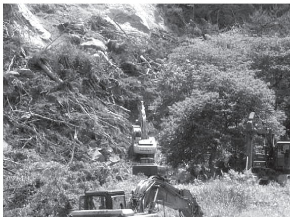
応急対策班（無人化機械施工班） 栗原市花山地先
