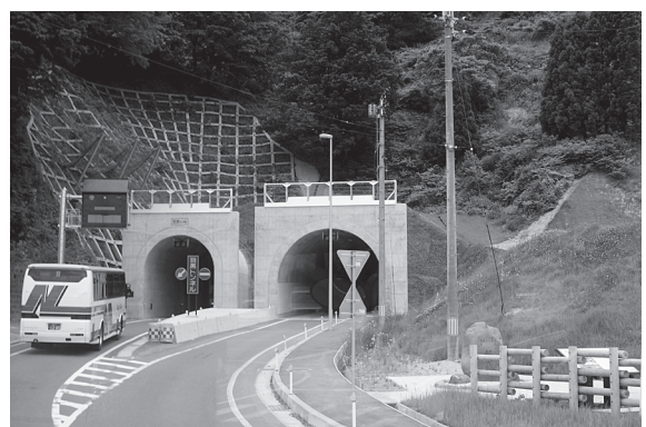
現地視察（羽黒トンネル：車窓）
