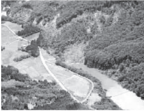
磐井川市野々原地区の河川閉塞状況
