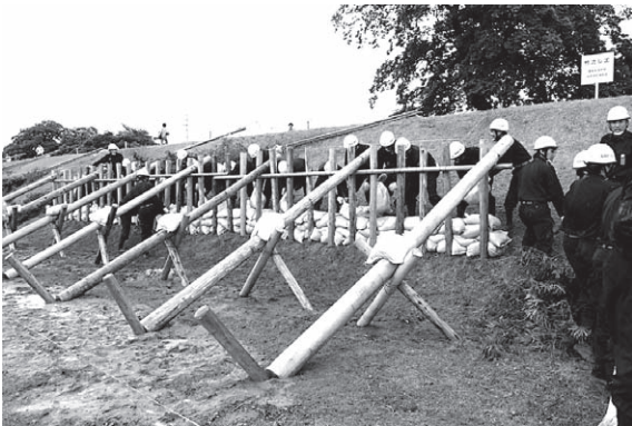
杭打積土のう工 (木曾川三川連合水防演習・ 複合型災害防災実働訓練)
