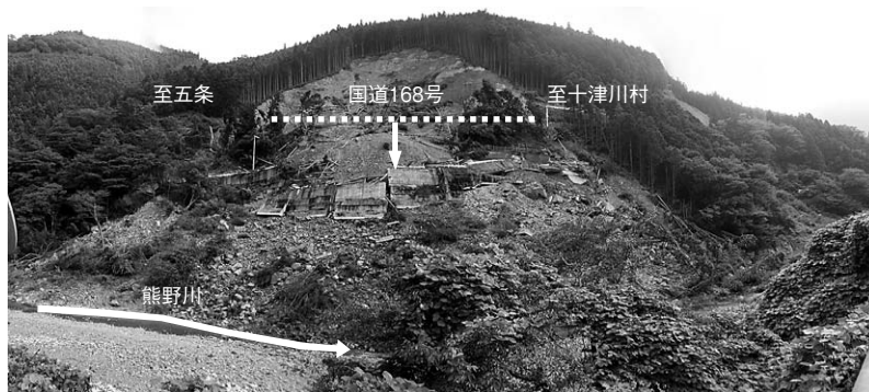
地すべり地全景（対岸道路より）
