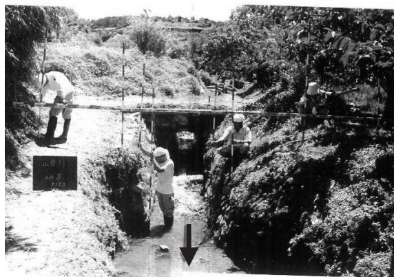
写真－2 被災後の状況
