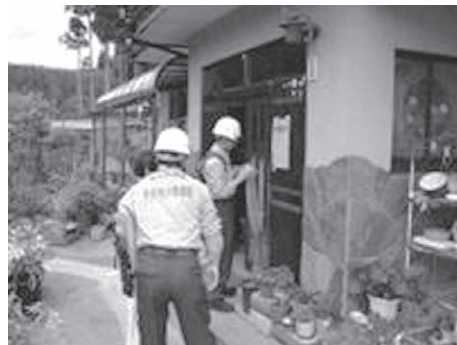
写真－6 建築物危険度判定
