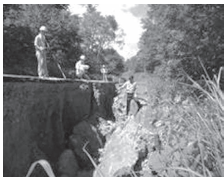
写真－5 道路被災状況調査
