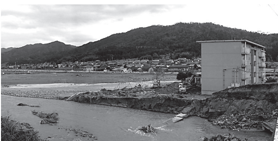
被災時（野田川堤防）
