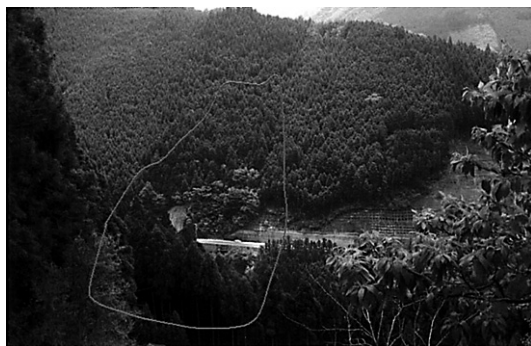
崩落前の斜面全景
