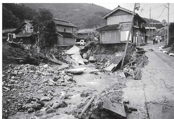
被災時（野田川上流部）
