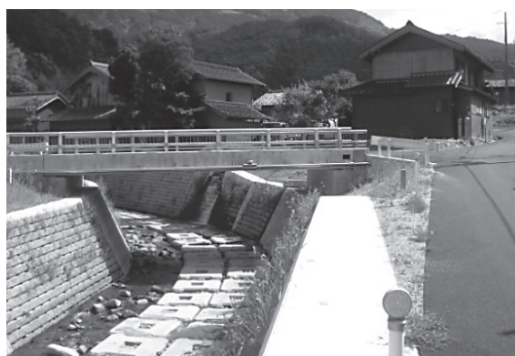
復旧後（野田川上流部）
