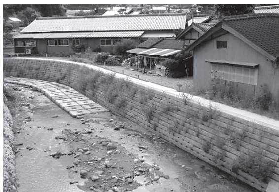
復旧後（野田川上流部）
