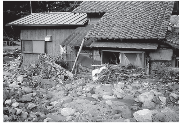
堤防決壊による家屋への土砂流入
