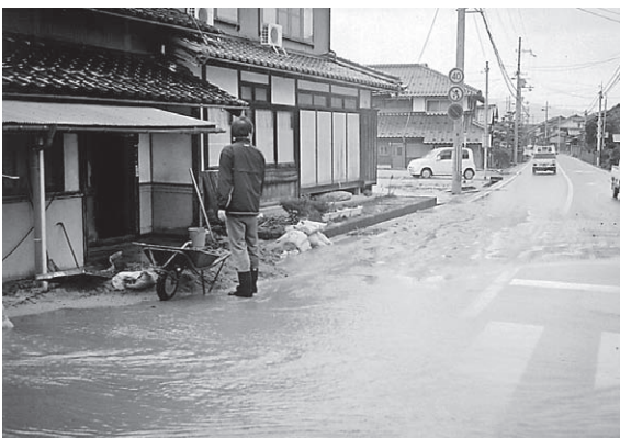
家屋への土砂流入
