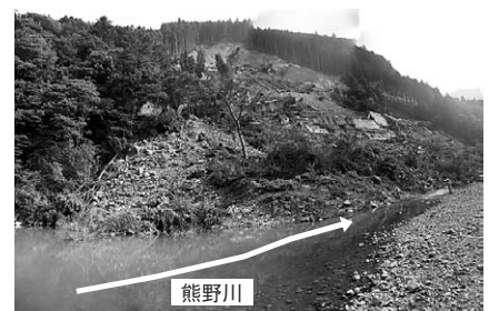
地すべり末端部上流側状況
