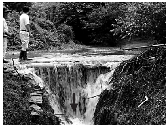
写真-1 被災直後の状況
