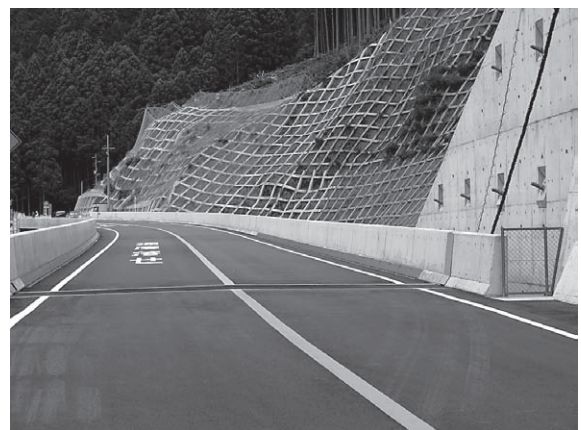
施工完了後の状況 (橋梁上)
