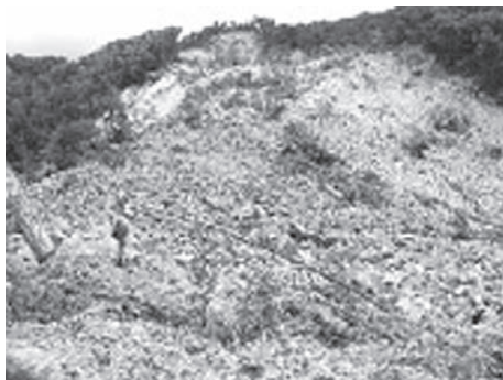
写真-8 高度技術指導班による河道閉塞箇所調査
