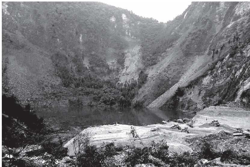
土砂撤去作業が続く、四川省安県肖家橋にできたせき止め湖 (写真提供：毎日新聞社)
