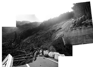
地すべり起点側状況
