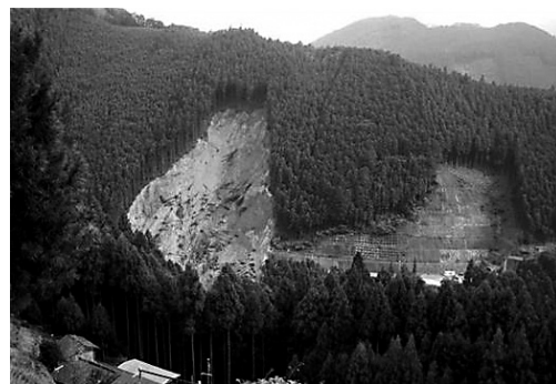
崩落後の斜面全景
