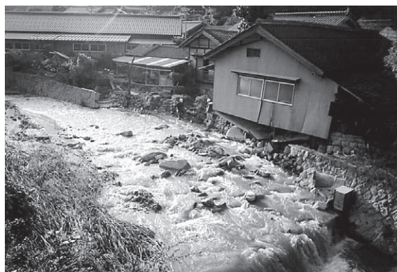
被災時（野田川上流部）
