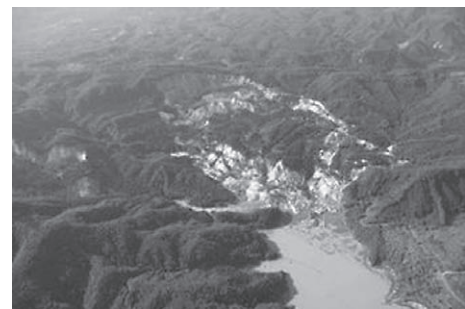
写真-2 みちのく号が撮影した荒砥沢ダム 上流部地すべり状況
