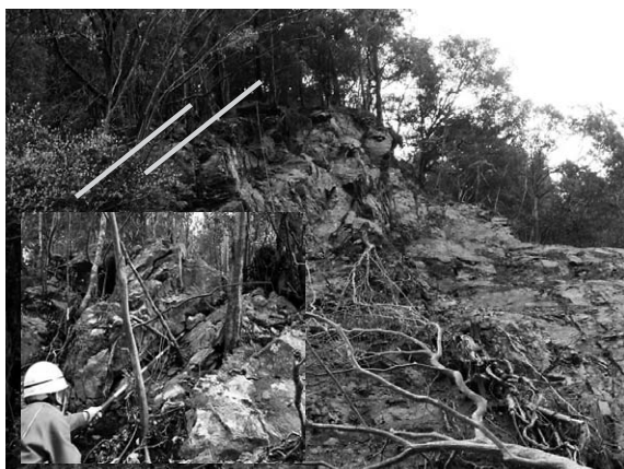
写真-3 滑落崖背後に認められる亀裂 (位置は概略)
