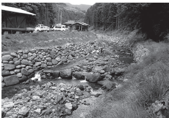
写真-22 モニタリング状況①
