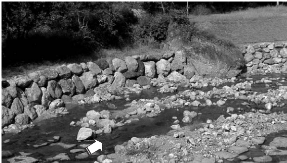
写真-11 完成（大転石の利用）
