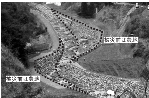
写真-6 完成(川なりの改良復旧)
