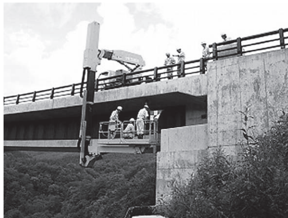
写真－6 橋梁点検車による査定状況
