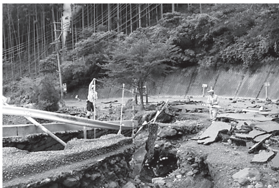
県道路面流失状況
