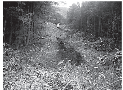
写真－8 大規模地すべり付近の迂回路施工状況
