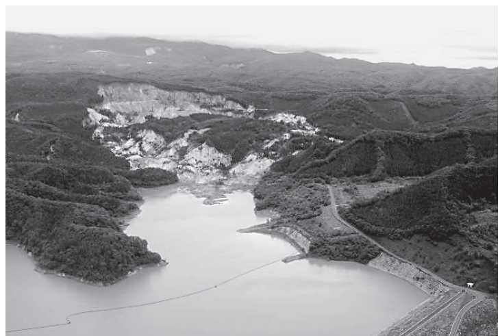
写真-1 荒砥沢ダム上流部の地すべり(その1)
