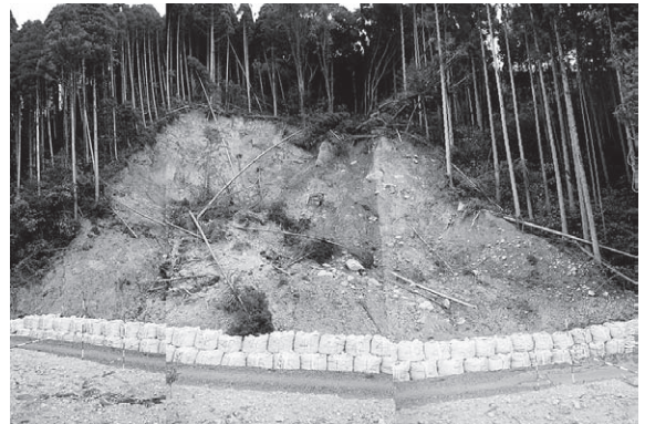
市道寺床1号線 被災状況
