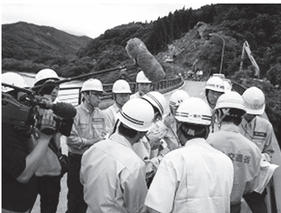
写真－4 TEC-FORCEによる現地指導状況
