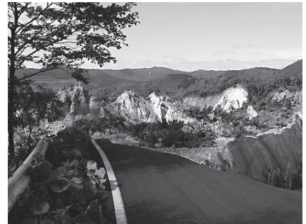
写真－7 市道の被災状況
