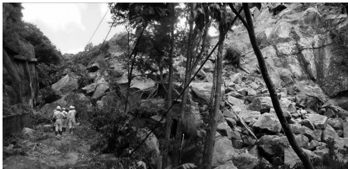
写真－5 県道築館栗駒公園線 被災状況
