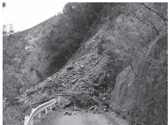
写真-1 県道の被災状況
