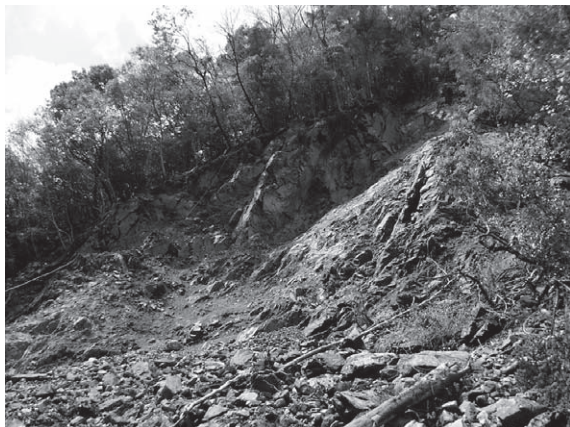
写真-2 流れ盤と鉛直の滑落崖
