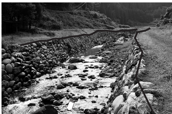
写真-7 完成(曲線的施工①)
