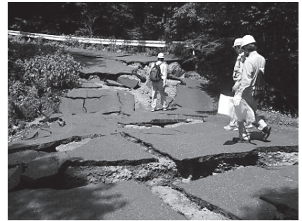
写真－6 市道の被災状況
