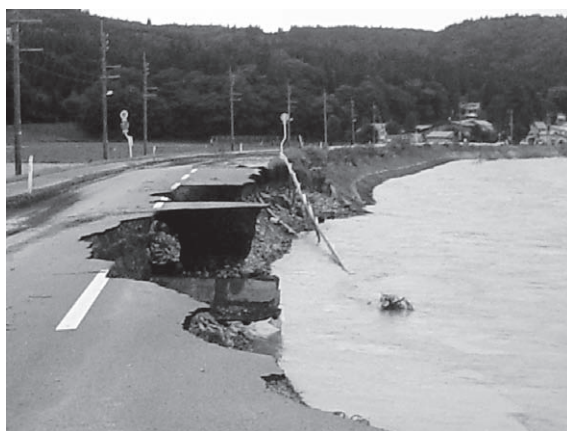
写真-2 被災状況
