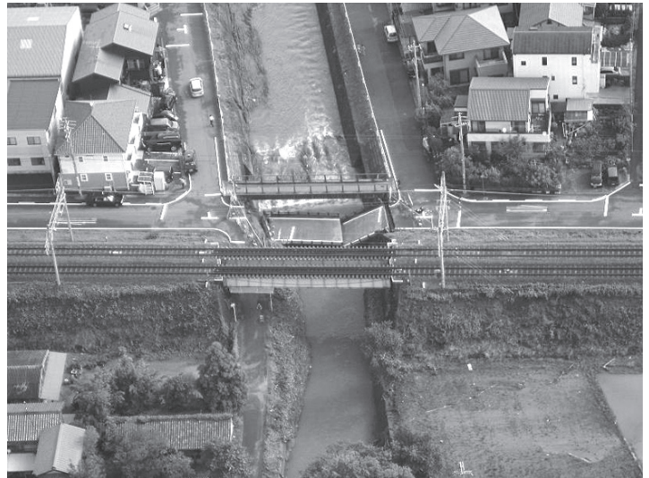
三河橋（愛知県岡崎市菟川新町地内）
