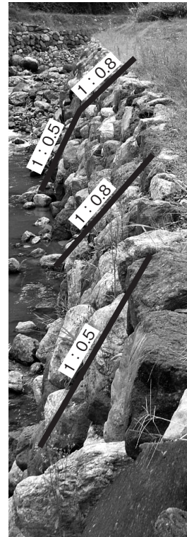
写真-8 完成(曲線的施工②)
