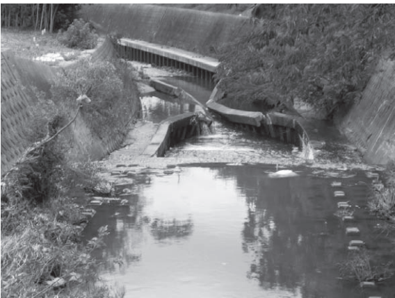
写真4-2 矢板護岸が崩壊した一級河川 山中川
