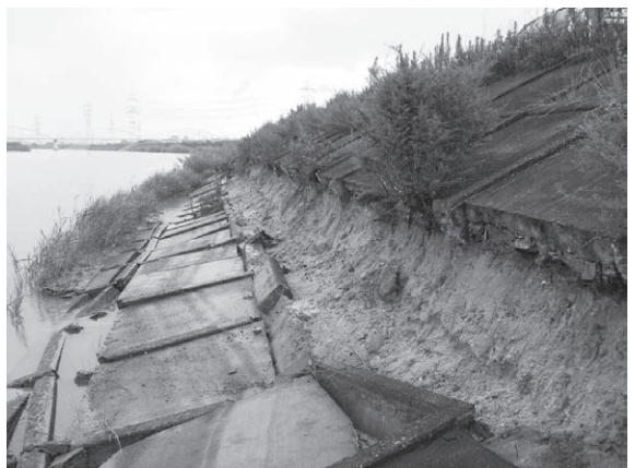
写真4-6 護岸が崩壊した二級河川 境川
