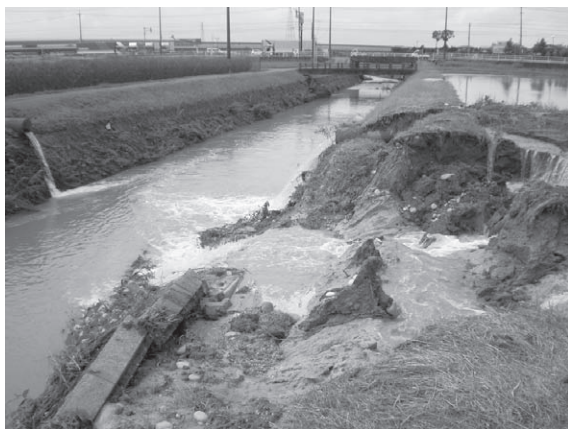
写真4-3 護岸が崩壊した二級河川 猿渡川
