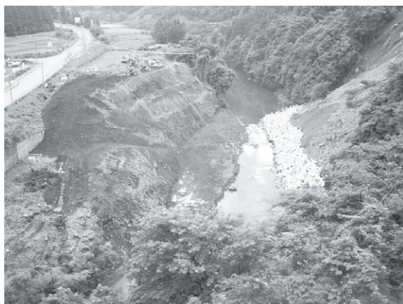
写真-14 応急工事完了(地すべり発生29日後)
