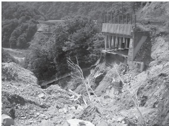
被災状況 (国)156号 (南砺市祖山地区内)
