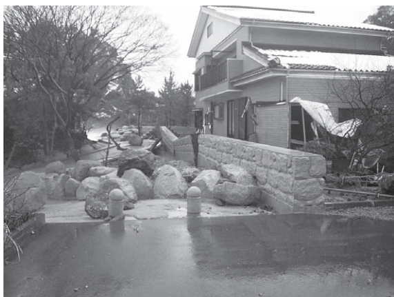
写真-7 水津地区海岸の住家被害
