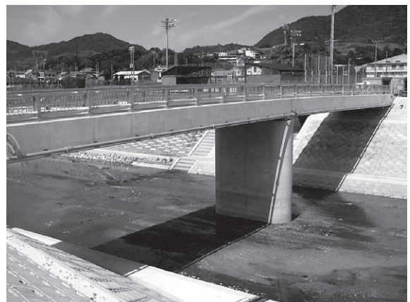
写真-14 激甚災害対策事業第1号の完成（洲本川：大森谷橋）
