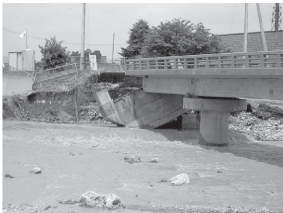
被災状況 (一)長楽寺福光線 (北信橋)
