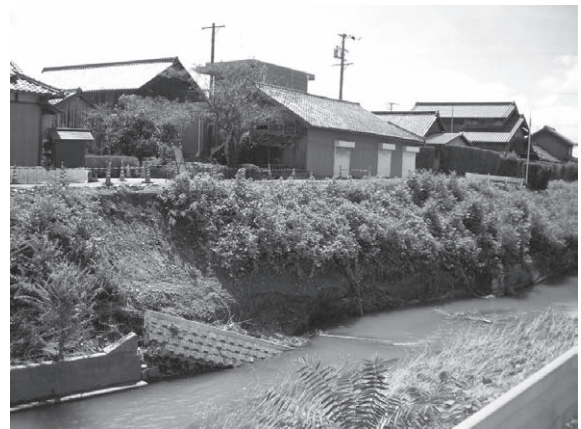
写真4-5 護岸が崩壊した一級河川 相見川
