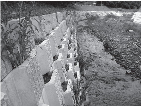
写真-15 ホタルブロック
