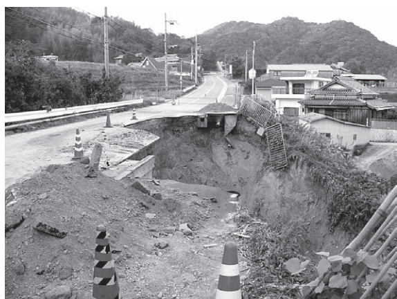
写真-2 通行機能の麻痺した県道洲本五色線
