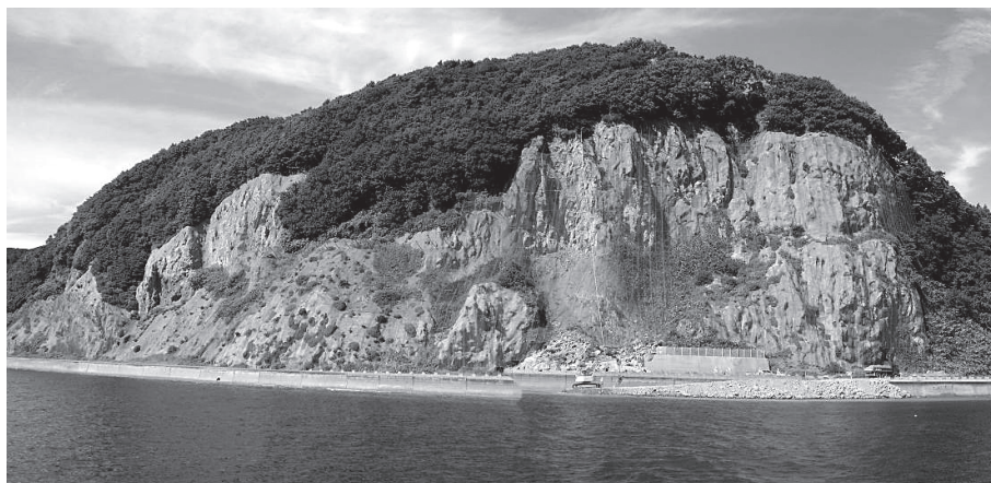
被災箇所海からの全景
