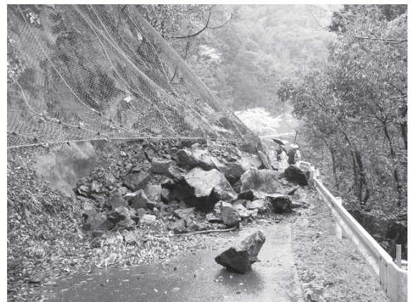
写真－4 町道小規模崩壊（被災箇所上流付近）
