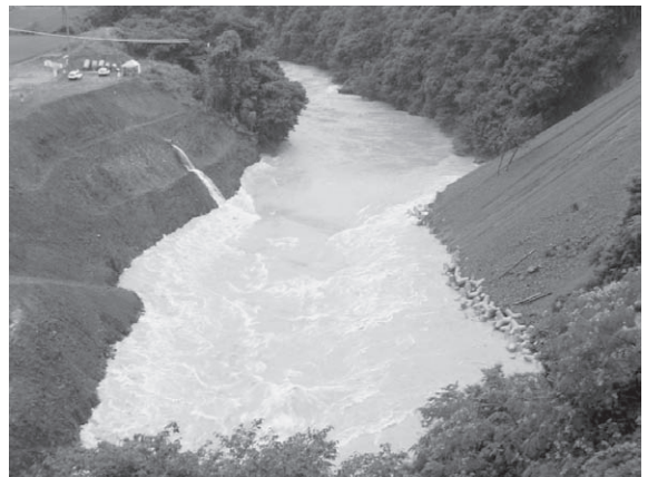
写真-15 応急工事完了後の出水状況(下流より望む)
