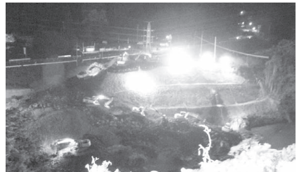
写真-10 応急河道掘削（24時間施工 20,000m³掘削・搬出）
