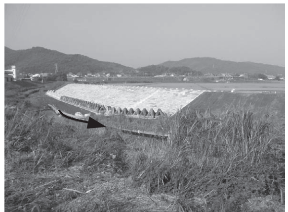
写真 4-11 応急復旧工事完了
