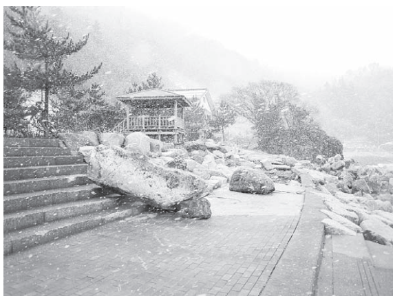
写真-6 水津地区海岸の護岸被災状況 ※4 t/個はあるかという巨石が海中から打ち上げられている
