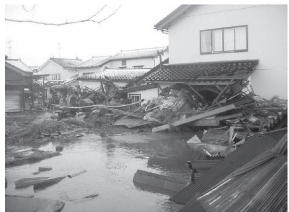
住家倒壊状況 入善漁港海岸（芦崎地内）
