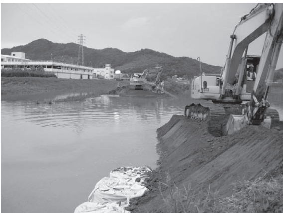
写真 4-9 水状況応急復旧状況
