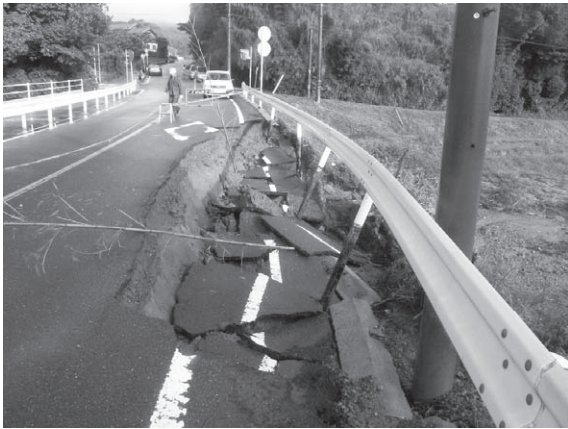
写真 4-7 道路の路肩崩壊現場 (幸田町)
