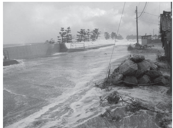
越波状況 入善漁港海岸（芦崎地内）
