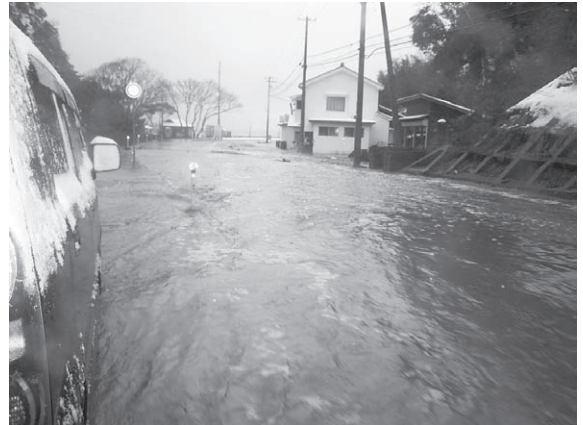
写真-3 越波により冠水した主要地方道佐渡一周線（写真-1の右手奥）
