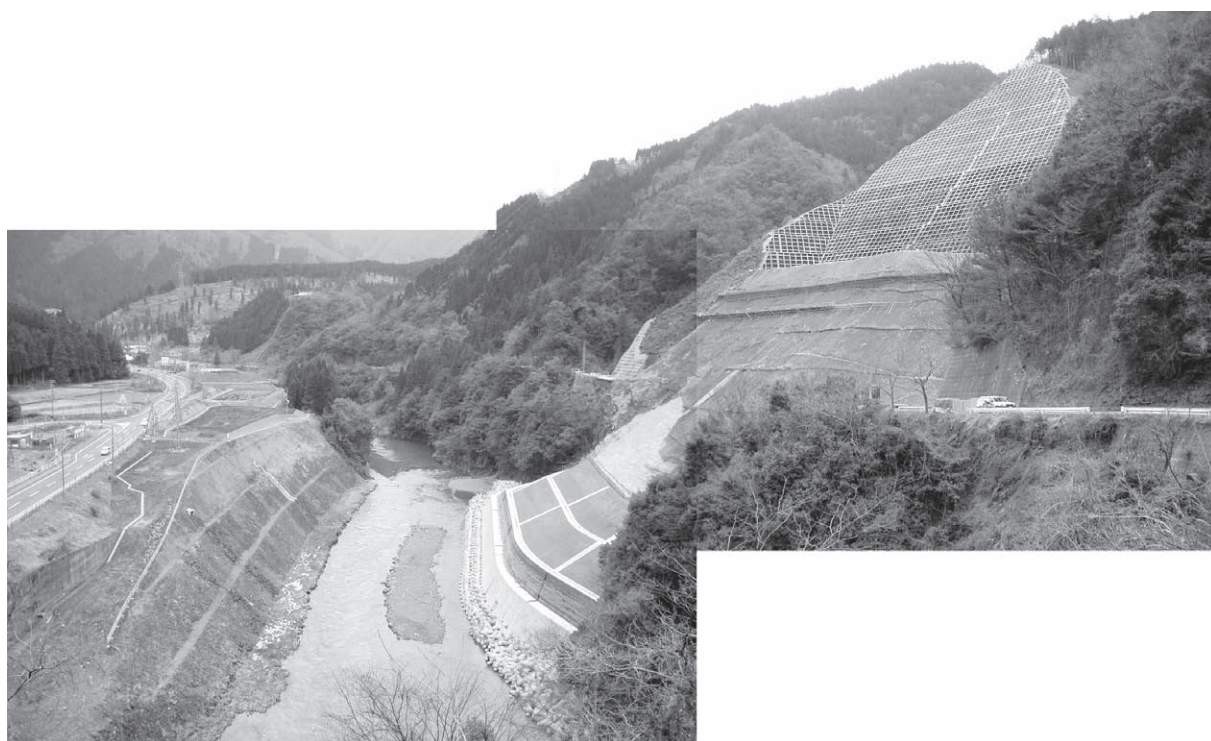
写真-17 河川災害復旧工事完了
