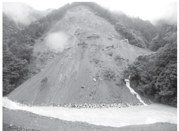
写真-16 応急工事完了後の出水状況(右岸より望む)
