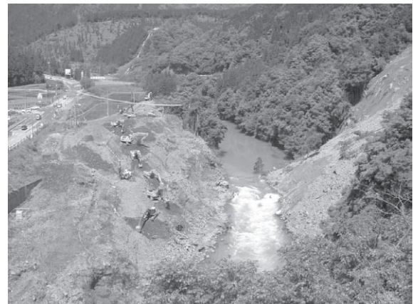
写真-11 応急河道掘削（重機のバケットリレー方式による搬出）
