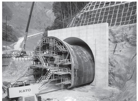
写真－6 河川トンネル（施工中）
