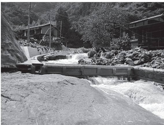
写真－ 4 村道住吉線（代行区間）を流れる 一級河川 底瀬川(南牧村上底瀬)
