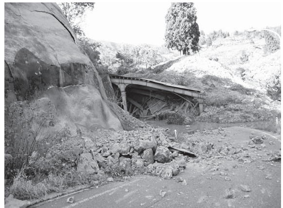
写真-3 スノーシェットの被災状況
