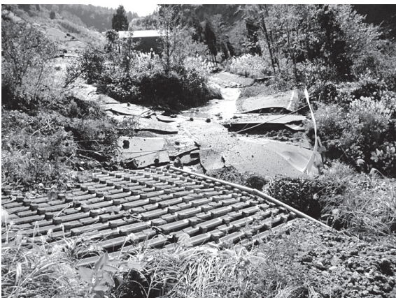
写真-2 地滑り内における道路の被災状況
