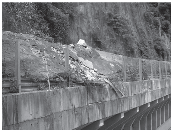
図-6 被災状況（落石防護柵）
