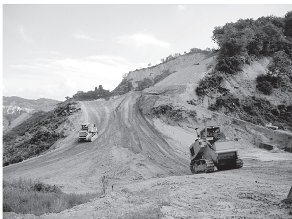
写真-5 スクレールドーザによる本線掘削状況
