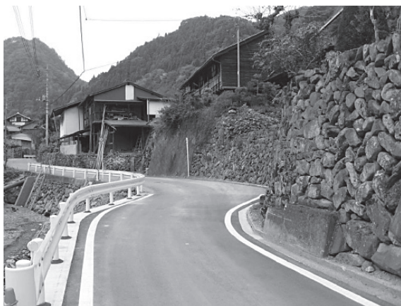
写真一 7 復旧工事が完成し元通りとなった 黒滝山小沢線（南牧村大塩沢）
