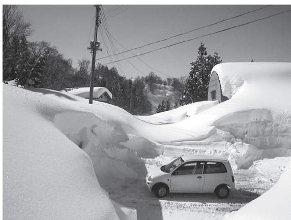
写真-4 工事再開前の積雪状況 (H18年3月)
