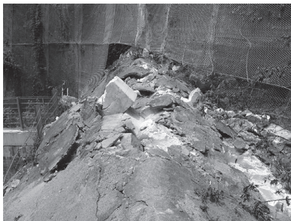
図-5 被災状況（落石防護柵上部）
