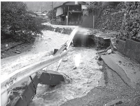
写真－ 3 黒滝山小沢線の崩壊により孤立状態となった南牧村大塩沢地区
