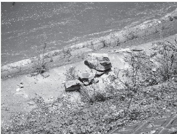
図-12 落石痕跡（河川護岸小段部）
