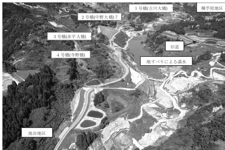
写真-9 本線完成状況 (H19年9月)
