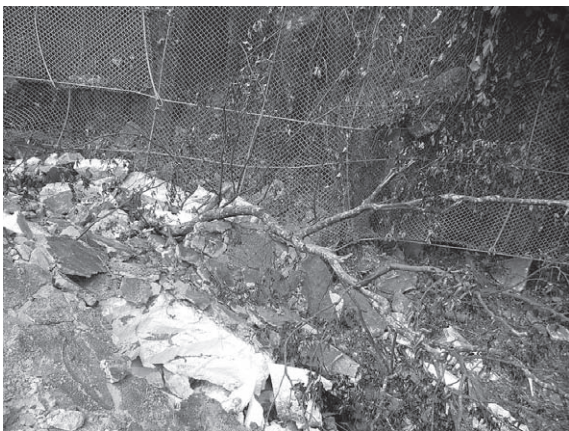
図-8 落石防止網に捕獲された岩塊
