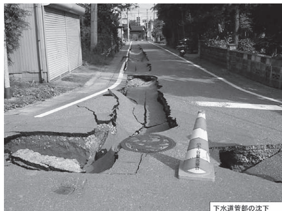
下水道官部の沈下
