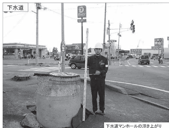
下水道マンホールの浮き上がり
