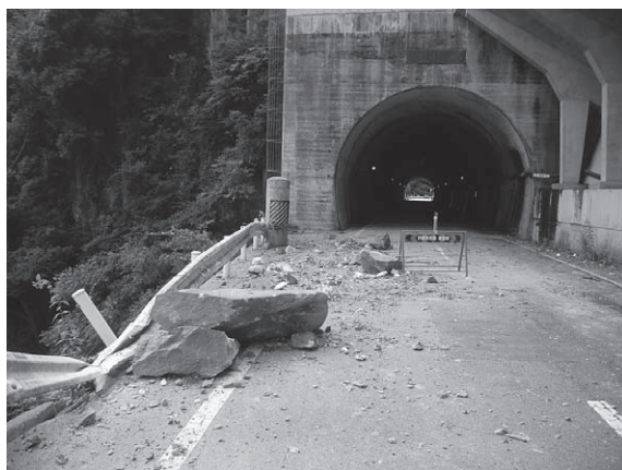
図-4 被災状況（道路部）
