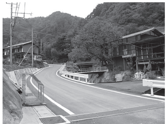
写真一 8 復旧工事が完成し元通りとなった 村道 住吉線(代行区間) (南牧村上底瀬)
