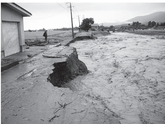
施設被災状況 写真－1 池川合流点付近における破堤状況
