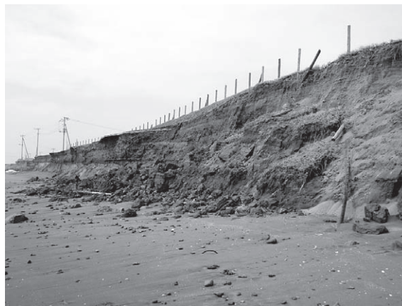
被災状況写真
