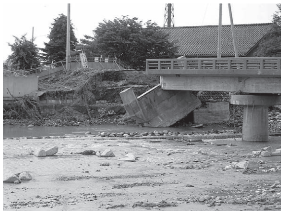
施設被災状況 写真－2 北信橋付近の護岸欠所状況
