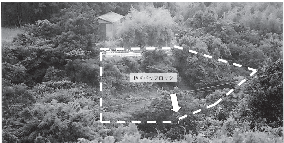
写真-1 被災箇所全景
