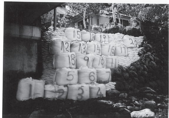
写真-3 仮復旧状況
