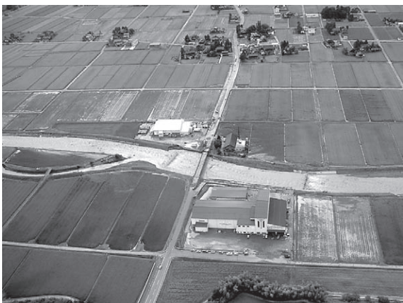
浸水状況 写真－2 北信橋付近における住宅、事業所等の浸水状況
