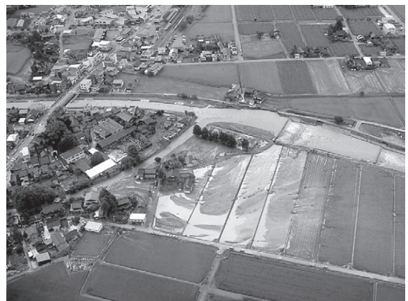
浸水状況 写真-1 池川合流点付近における住宅、水田の浸水状況
