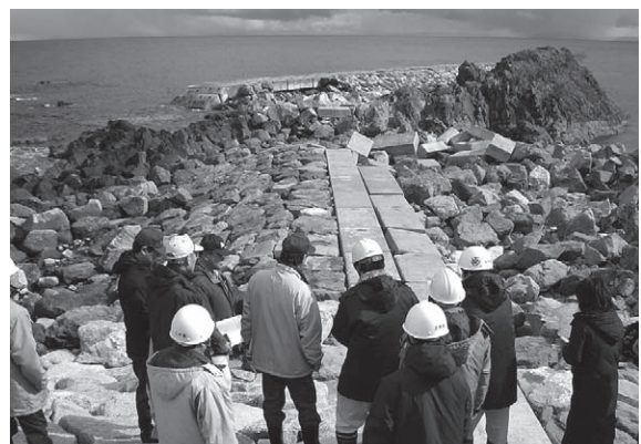
災害復旧調査の実施状況 （新潟県佐渡市）
