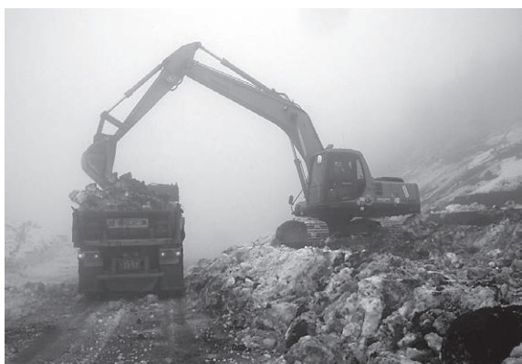
写真－7 被災施設と雪崩堆積物を除去
