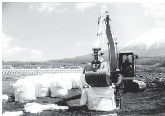
写真－8 遊砂地に隣接するヤードで大型土のうを製作
