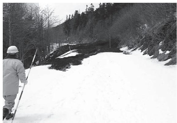
写真-5 被災直後の現地踏査
