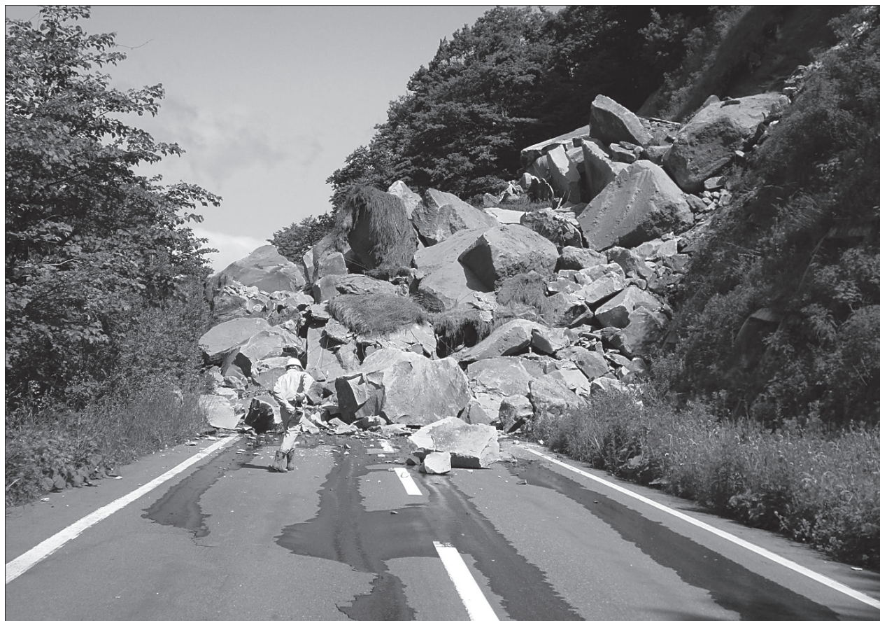
平成20年6月14日発生 岩手・宮城内陸地震（一般国道342号 一関市）
