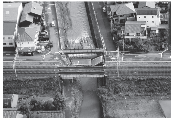
市道 蓑川竜泉寺川堤 2 号線 三河橋(愛知県岡崎市蓑川新町地内)
