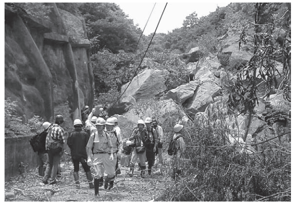
主要地方道 築館栗駒公園線 (宮城県栗原市)
