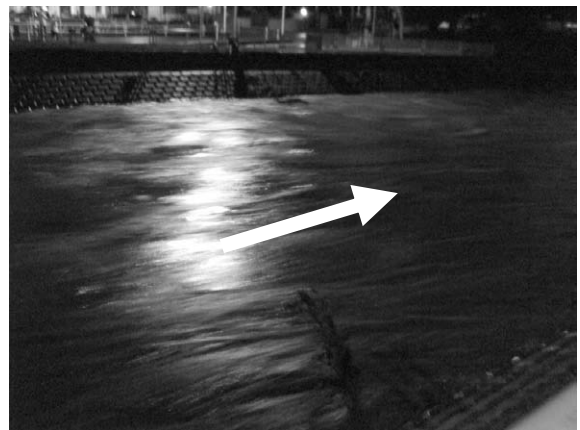
出水状況 (二級河川境川 大和市深見地先)
