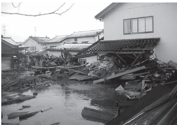
浸水被害の状況 （富山県下新川群入善町）
