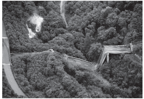
一般国道 342号線 祭時大橋 (岩手県一関市)
