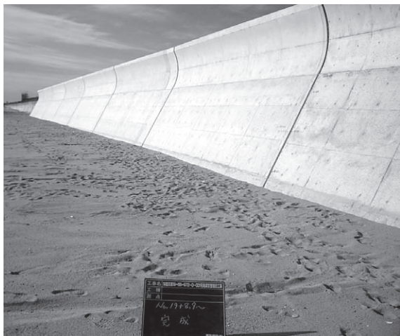
復旧が完了した区間の直立式護岸
