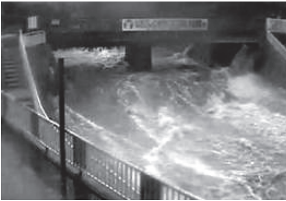
都賀川の出水状況 (兵庫県神戸市)
