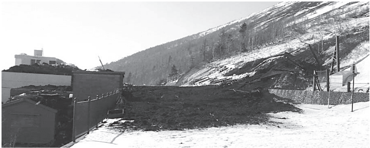
写真-3 新5合目の被災状況（白い建物の手前には臨時の派出所があったが雪崩により流失）
