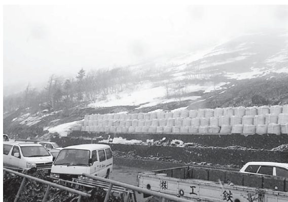
写真－9 大型土のう設置完了
