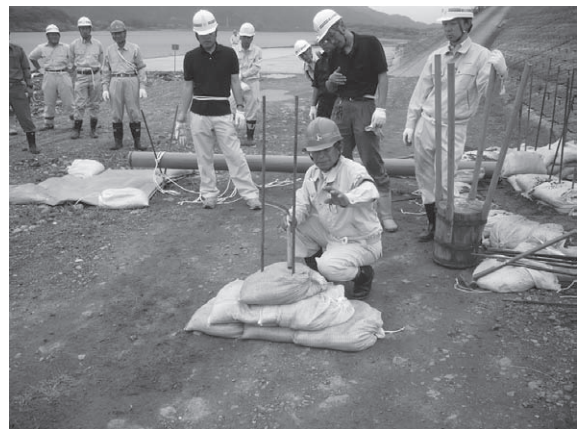
土のう積みの手順と杭の打ち方
