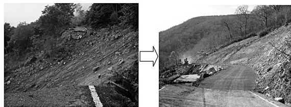
道路の崩落箇所 暫定断面での仮復旧状況
