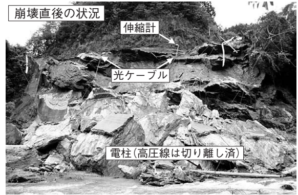
写真-8 崩壊状況（8/7撮影）
