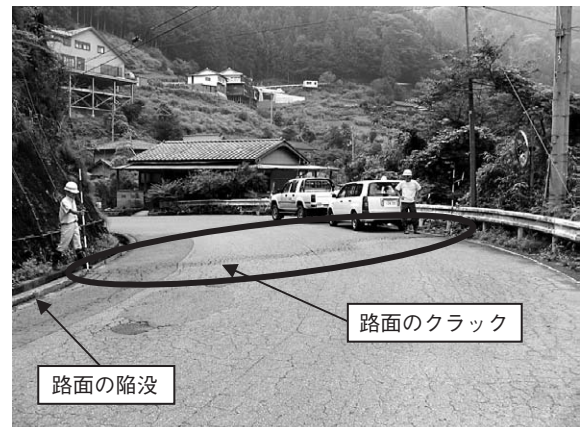
写真－1 路面の沈下、クラック（7/30撮影）
