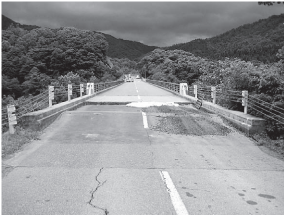
写真-3.9 国道342号仁郷橋橋台背面の変状
