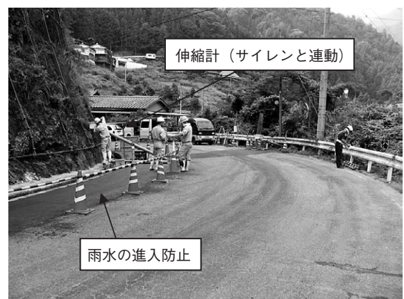
写真－3 応急手当と観測機器設置（8/1撮影）
