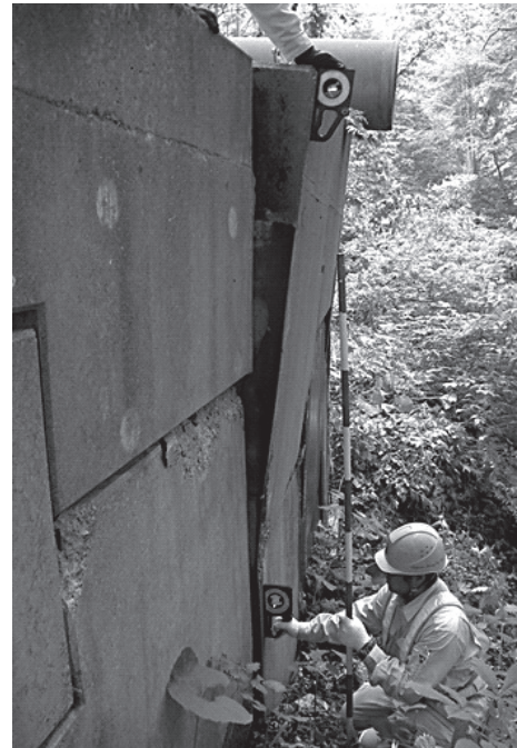
写真-3.11 補強土擁壁の傾倒
