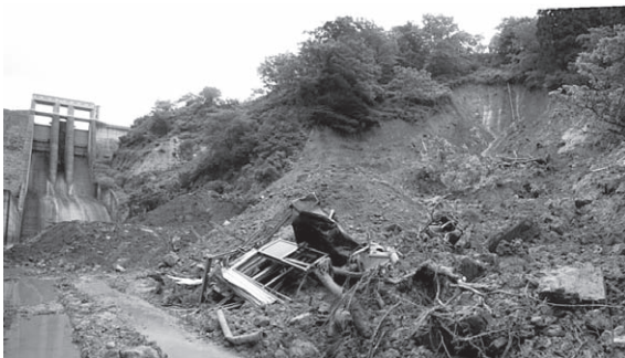
写真-3.4 皆瀬ダム下流の斜面崩壊
