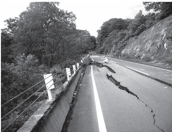
写真-3.10 国道398宮城県境付近 重力式擁壁の傾倒による路面の変状
