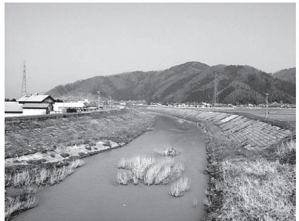
改修前（水窪橋 下流）
