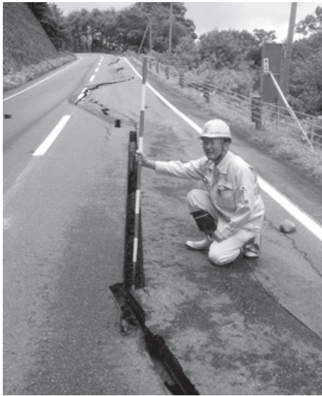
写真-3.8 縦断方向の亀裂 (片切片盛土部)
