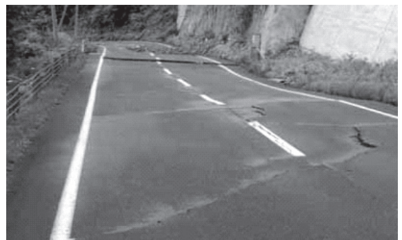
写真-3.7 沢埋盛土部における路面の亀裂
