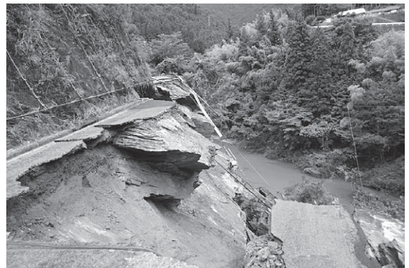
写真-6 崩壊直後 (8/7撮影)
