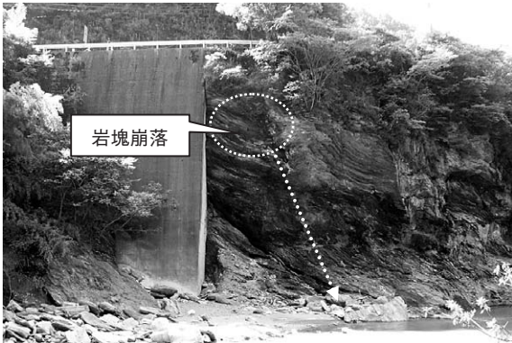
写真-5 赤印部の岩塊2~3m³が崩落 (8/6撮影)
