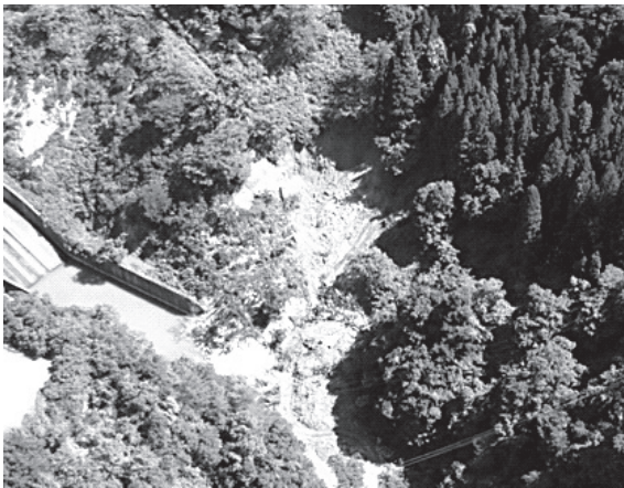
写真-3.3 皆瀬ダム下流の斜面崩壊
