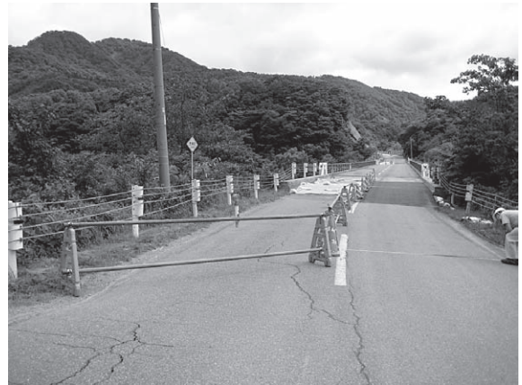
写真-4.2 国道342号仁郷橋仮復旧状況 (写真-3.9 箇所の仮復旧状況)
