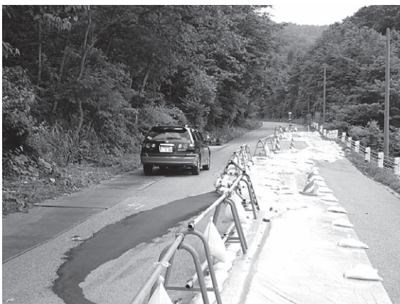
写真-4.1 仮復旧状況
