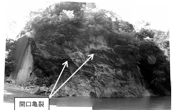
写真－2 岩壁に水平開口亀裂を確認（7/31撮影）
