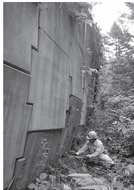
写真-3.12 補強土擁壁の変形
