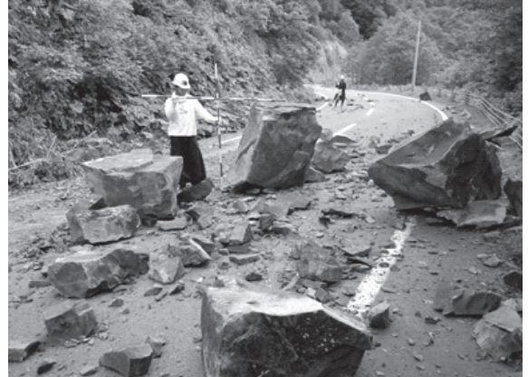
写真-3.5 国道342号の落石状況
