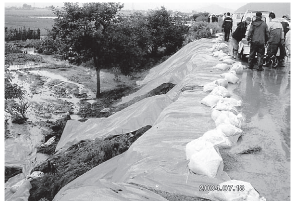
鞍谷川 水防状況
