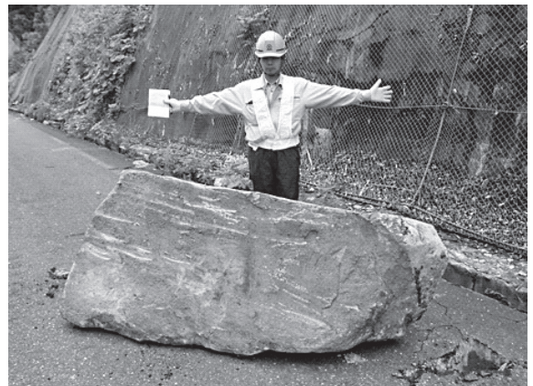
写真-3.6 仁郷大湯線落石状況
