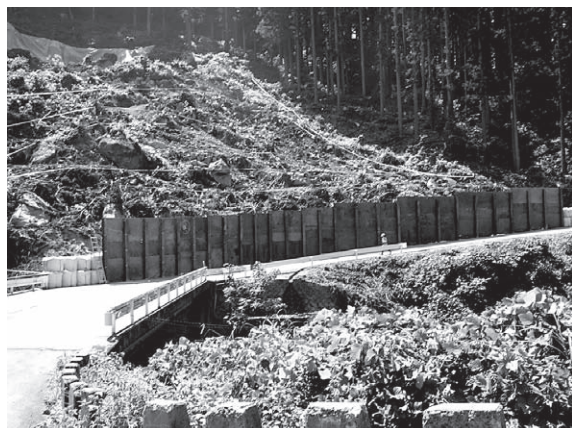
写真-4.3 黒滝橋付近仮設防護柵設置状況 (写真-3.1 箇所参照)
