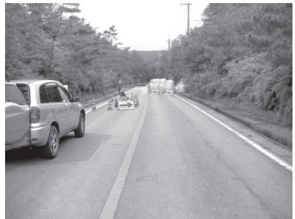
写真 1-3 国道331号 応急工事後
