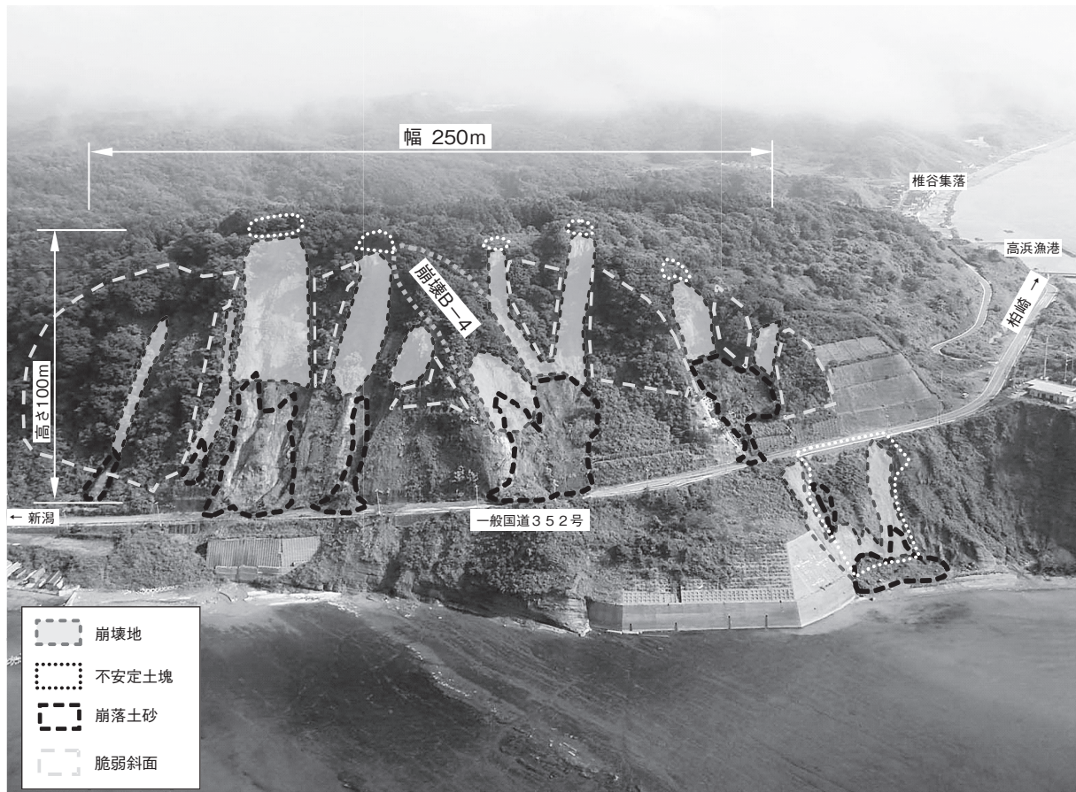
写真-1 斜面の崩壊状況
