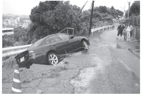
写真 3 西原町 棚橋 9 号線 被災状況
