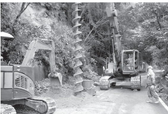
写真 5-1 県道 2 号線 応急対策状況
