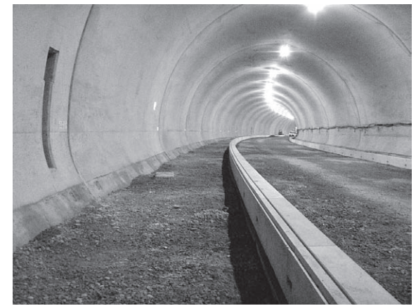
写真－7 現在の抗内の状況
