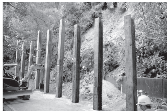
写真 5-2 県道 2 号線 応急対策状況
