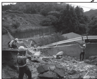
▲ 被災状況調査
