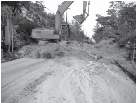
写真 1-2 国道331号 応急工事状況
