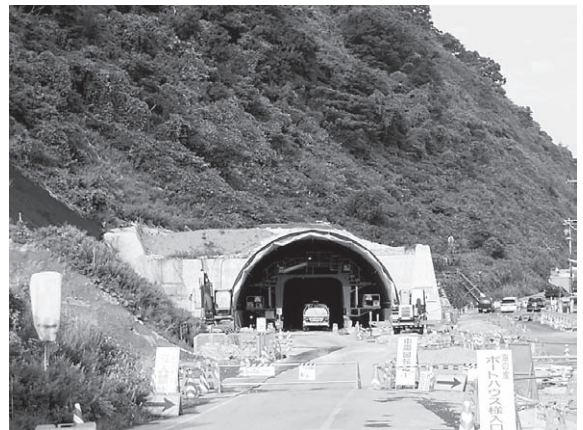
写真－8 現在の終点側坑口の状況
