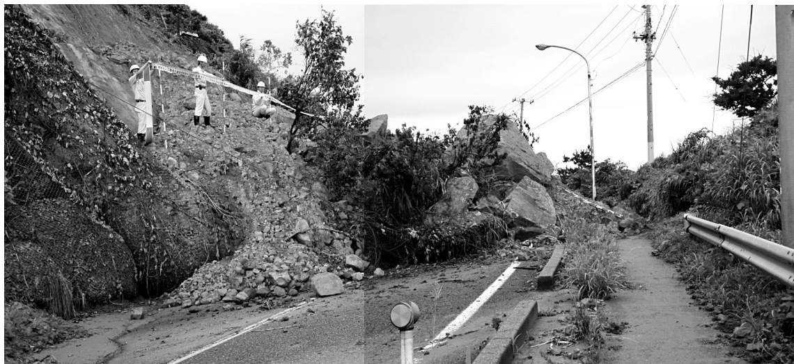
写真-3 現道に崩落した土砂
