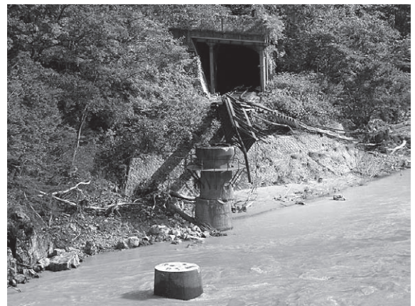
写真-2 JR 鉄道橋の流失（宮川町地内）
