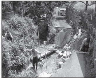
▲ 被災状況調査
