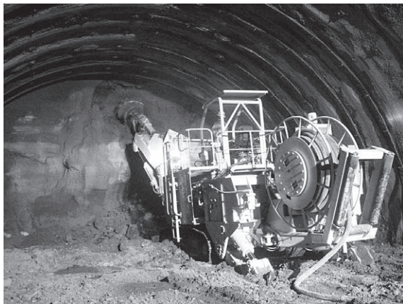
写真－6 ロードヘッダによる機械掘削
