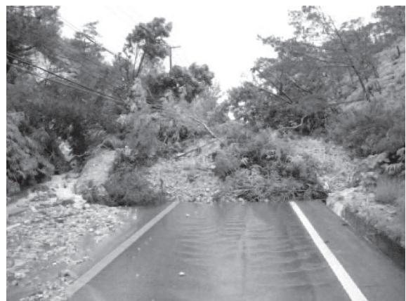
写真1-1 国道331号 被災直後
