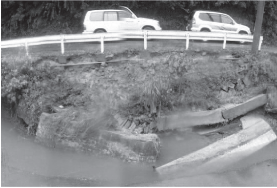
写真 2 名護市 ゲーヤ川 被災状況
