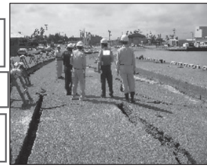
▲ 被災状況調査
