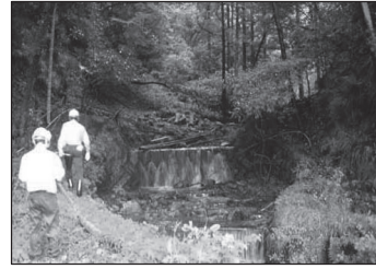
▲ 被災状況調査
