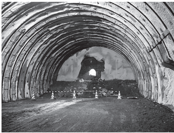
写真－5 貫通の瞬間（平成21年4月）
