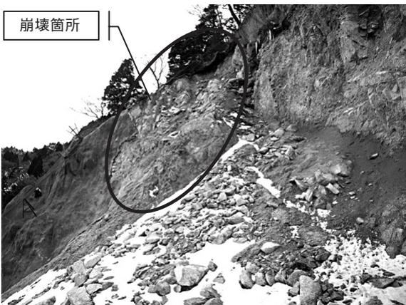
写真-8 斜面左側の崩壊写真 (平成21年2月撮影)
