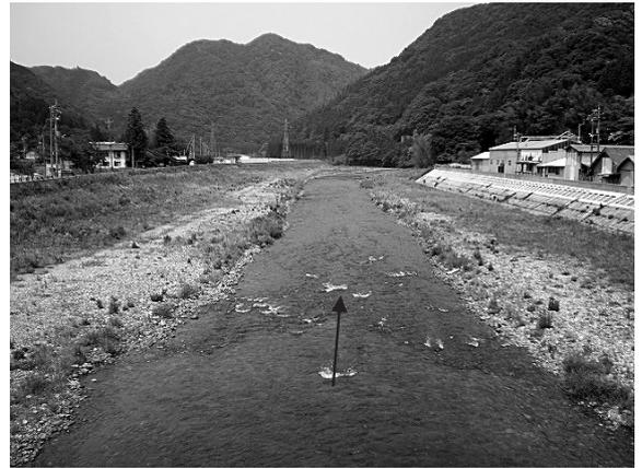
水際部は切り放しで河床掘削は既設に対し平行移動
