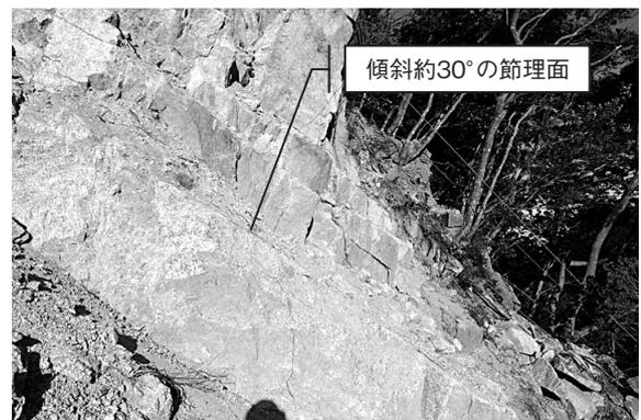
写真-9 花崗岩にみられる流れ盤方向の節理 (平成20年9月撮影)
