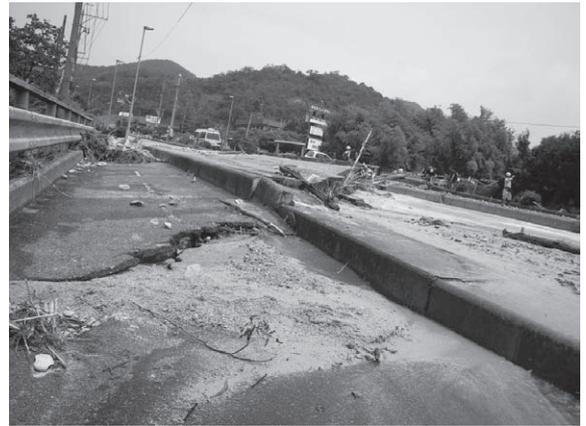
写真－3 国道262号の被災状況
