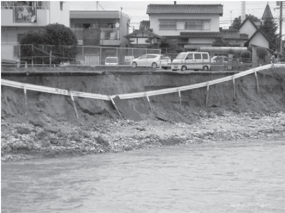
写真－1 那珂川の護岸崩壊状況
