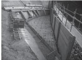
軽量盛土工～鉄筋組立完了（中間床版）
