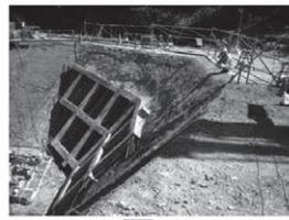
法面工～法面吹付けコンクリート (t=5cm)
