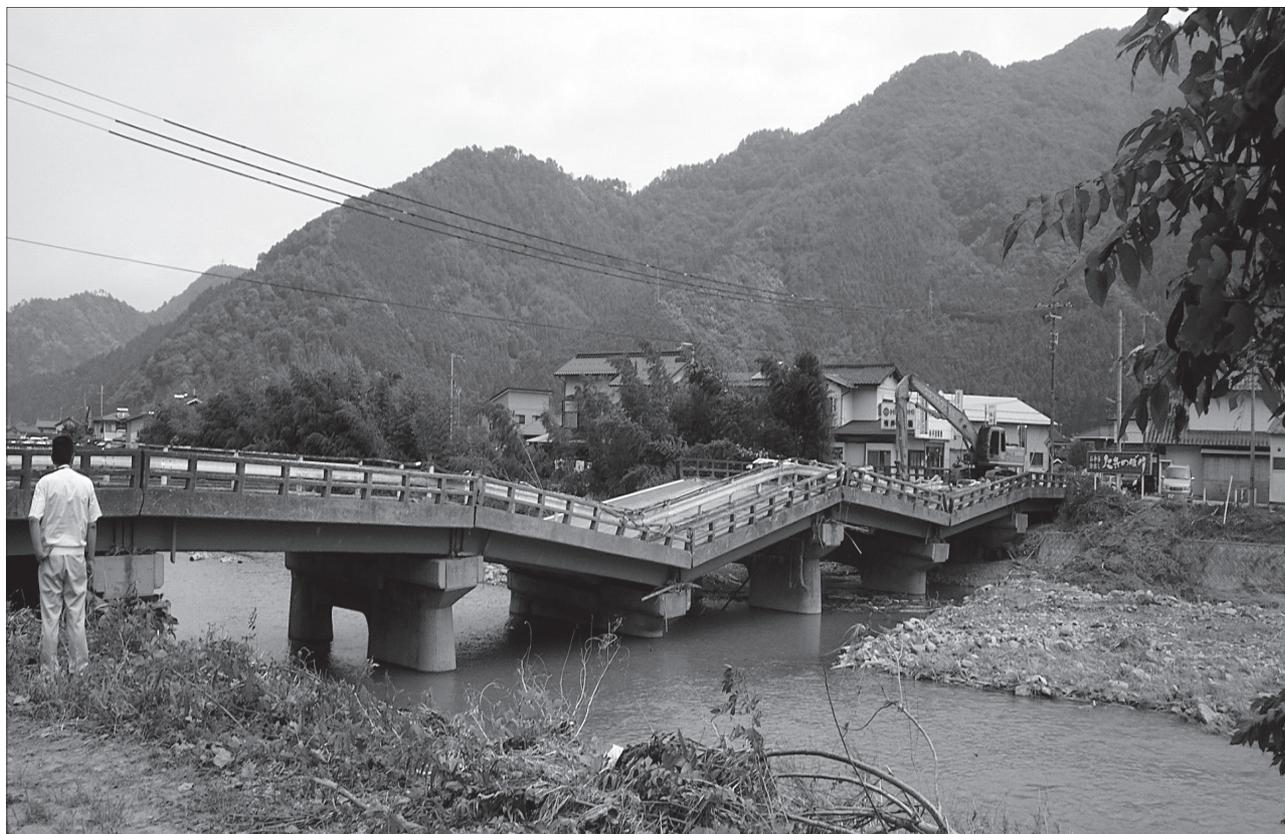
台風第 9 号による被災 (市道新井旧国道線：橋梁の被災状況 (兵庫県朝来市))
