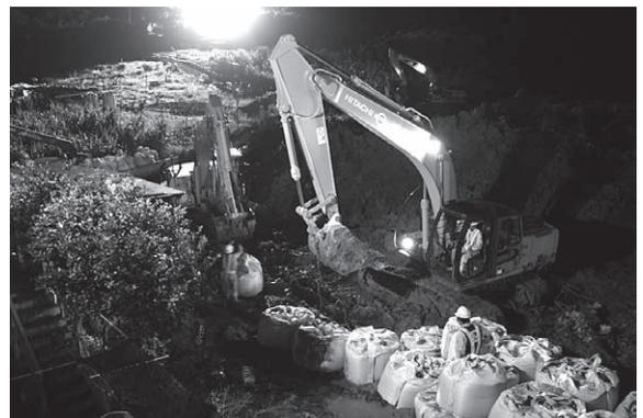
写真-6 土のう設置および土砂搬出
