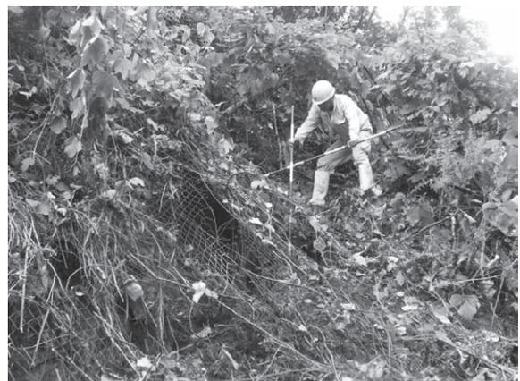
押出により発生した開口亀裂
