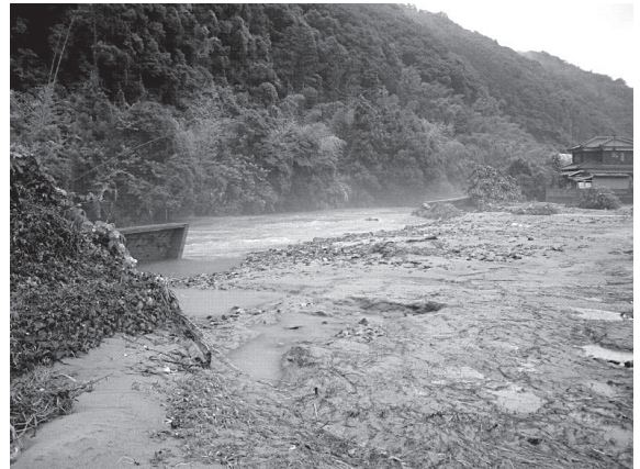
周南市戸田地区 2級河川夜市川 堤防決壊状況
