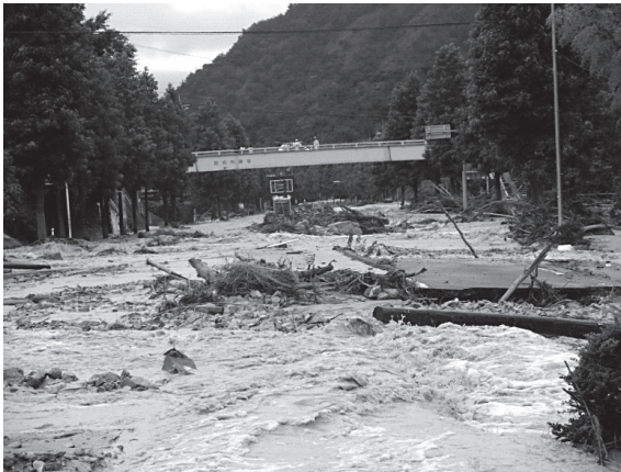
防府市上右田地区 国道262号 土石流発生状況
