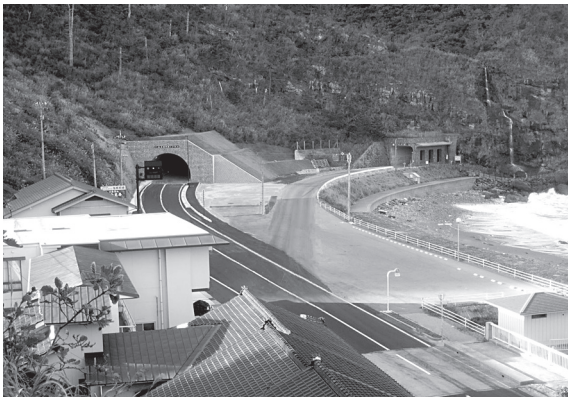
写真-4 完成した「八世乃洞門新トンネル」(珠洲側)
