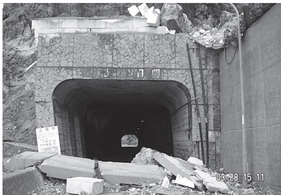
写真-1 被災した八世乃洞門
