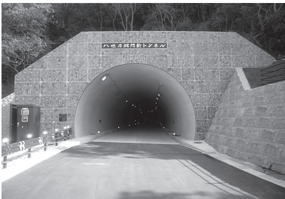
写真-5 「八世乃洞門新トンネル」輪島側坑口
