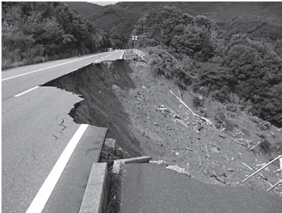
山口市吉敷畑地区 国道435号 道路法面崩壊状況
