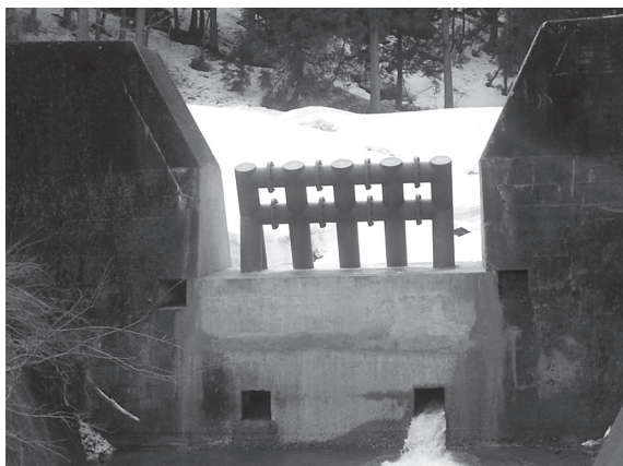
細野砂防堰堤 改良後
