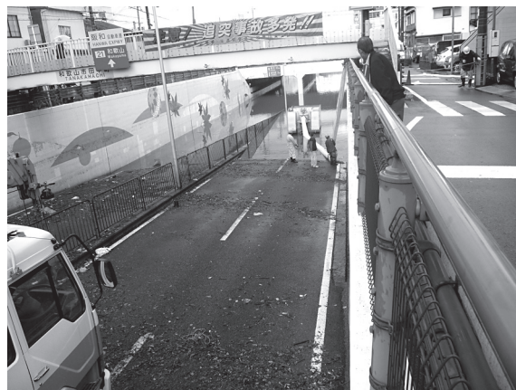
写真-4 道路冠水へのポンプ排水状況
