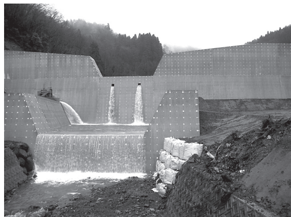
山河原堰堤 嵩上げ後
