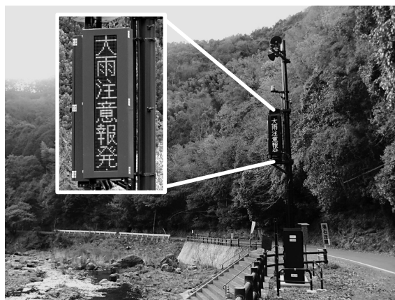
写真-1 河川警報装置(電光表示はスクロールタイプ)
