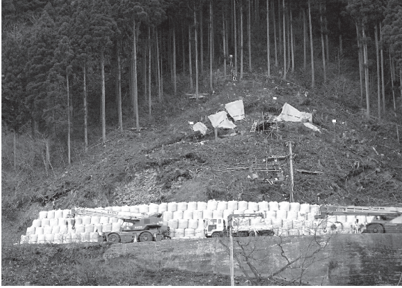
応急対策工の施工状況
