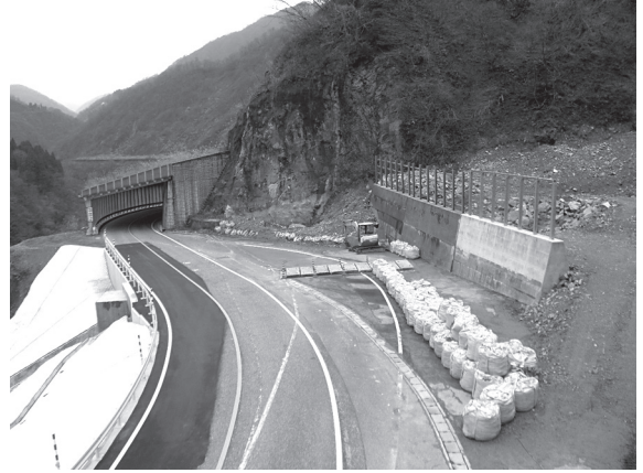
写真－3 復旧工事完了時
