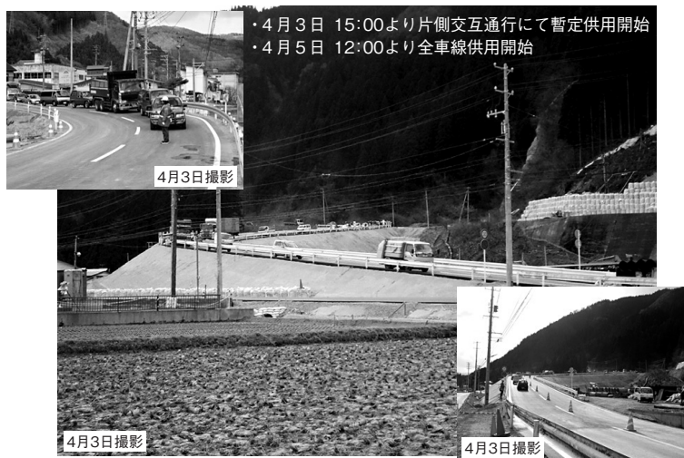
仮設道路完成・供用開始
