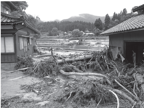
流木被害状況
