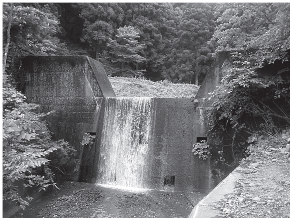
細野砂防堰堤 改良前
