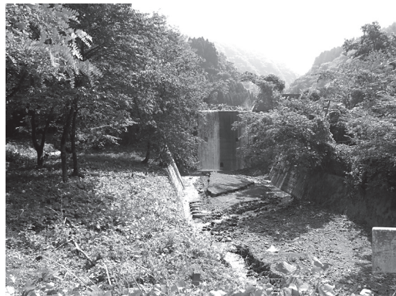
山河原堰堤 嵩上げ前
