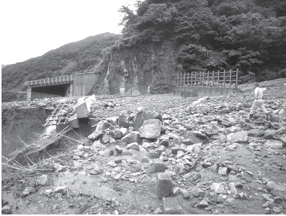
写真－2 災害発生時
