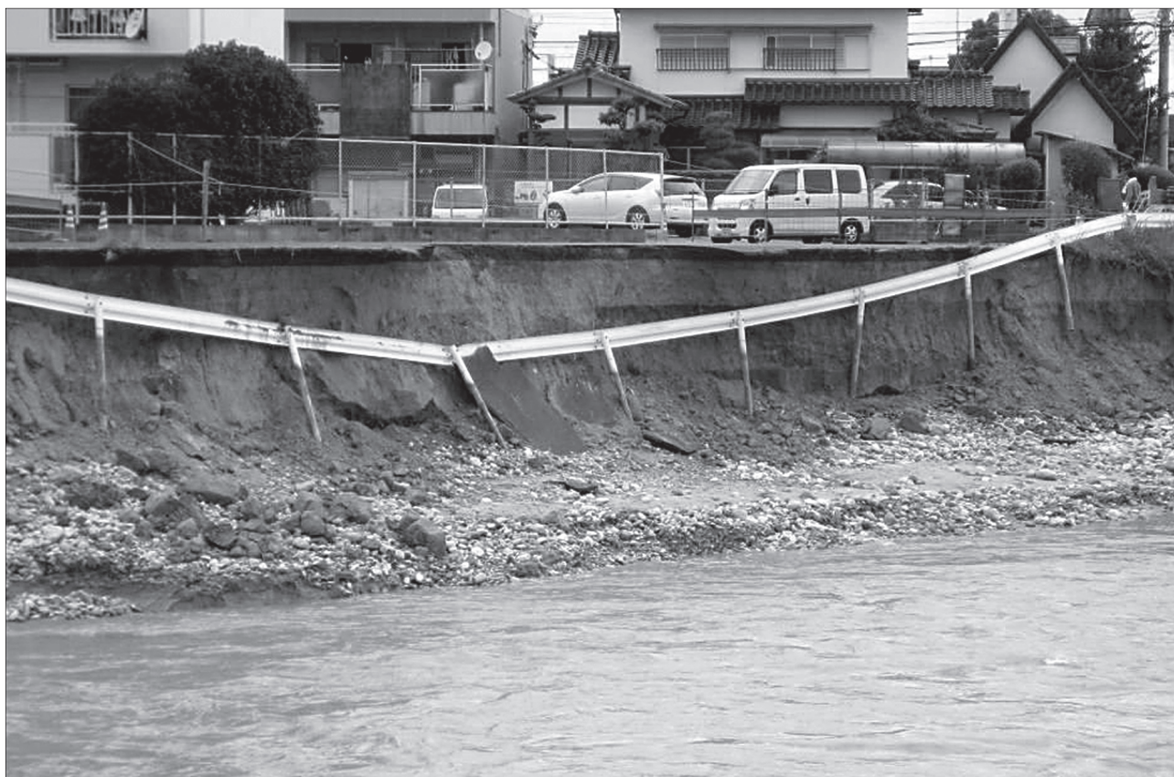
平成21年7月中国・九州北部豪雨による被災状況 一級河川那珂川(福岡県那珂川町)
