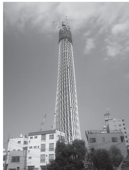
建設中の東京スカイツリー
