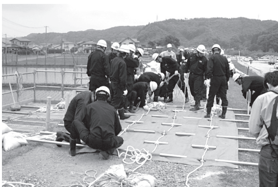
シート張り工
