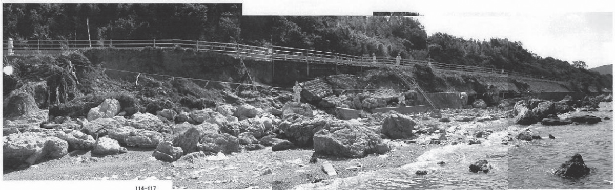
写真-1 被災箇所全景
