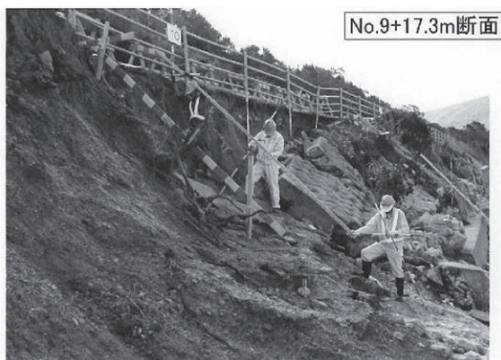
写真-2 被災箇所調査状況
