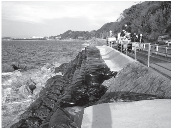
写真－4 応急工事後
