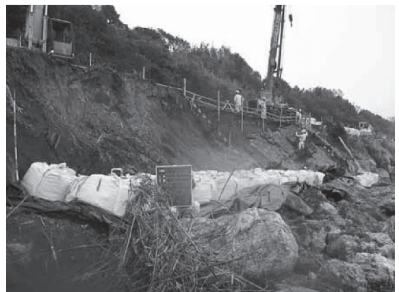
写真-3 応急工事施工状況
