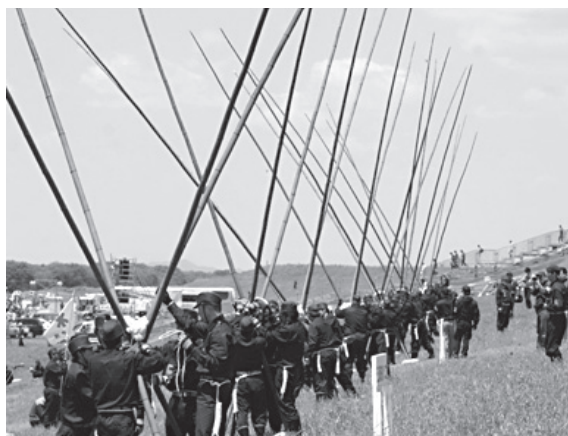
崩壊防止工法 五徳縫い工
