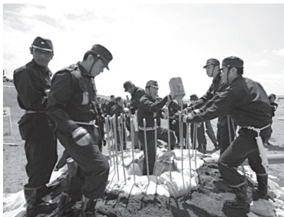
漏水防止工法 釜段工実施状況
