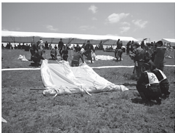
洗掘防止工法 表むしろ張り工 (防水シート使用)
