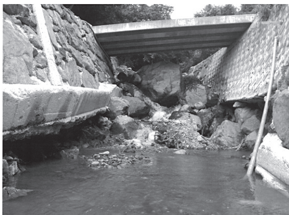
岩屋川（福智町）の災害状況
