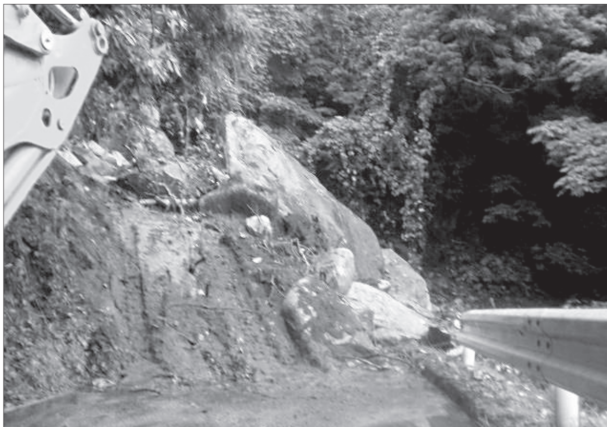
平成22年6月梅雨前線豪雨による道路災害(鹿児島県内之浦佐田線)
