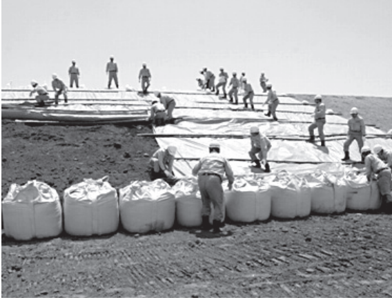
国土交通省職員による応急復旧訓練
