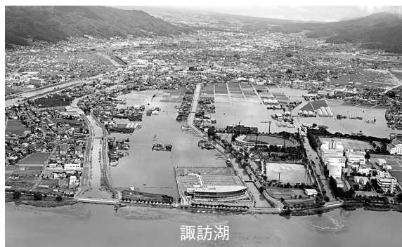
写真-1 浸水被害を受けた諏訪市内
