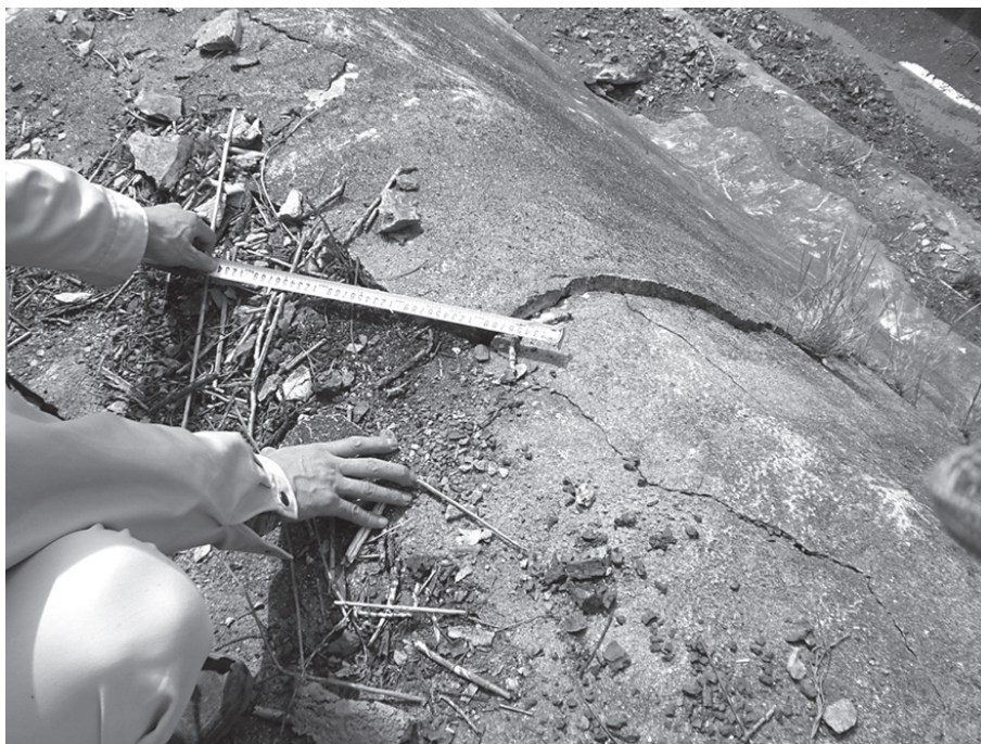
残存施設の亀裂損傷状況
