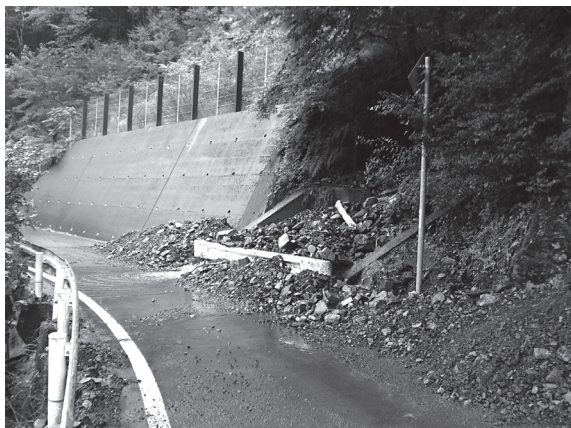
写真-2 土砂流入状況
