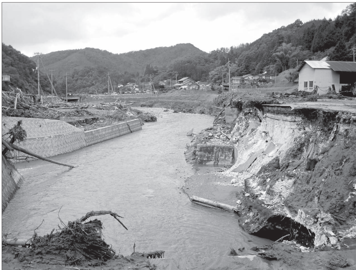
平成22年7月梅雨前線豪雨による被災状況 大津恵川 (広島県庄原市川北町)
