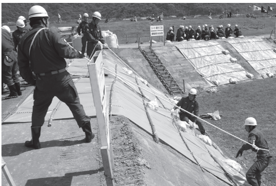
シート張り工(総合防災訓練 in 熊本)
