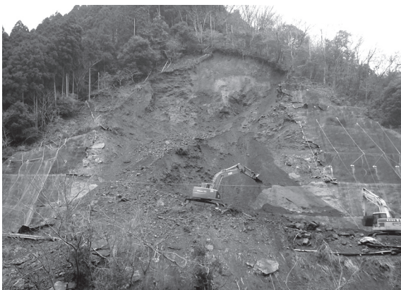
崩土除去の様子
