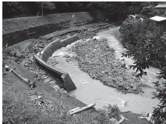
写真-6 白井川被災状況
