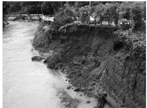
写真－3 鹿児島県曾於市1級河川溝之口川・庄内川の被災状況
