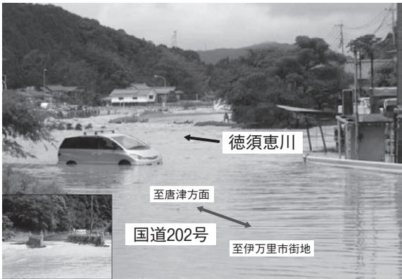
写真－6 越水状況
