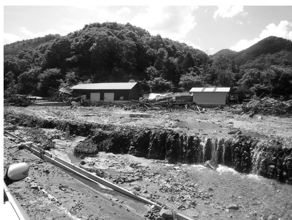
写真－ 9 広島県庄原市篠堂地区の被災状況
