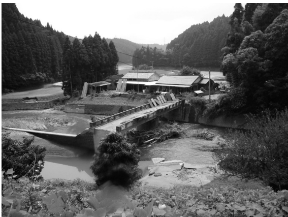
写真－2 宮崎県都城市1級河川庄内川の被災状況
