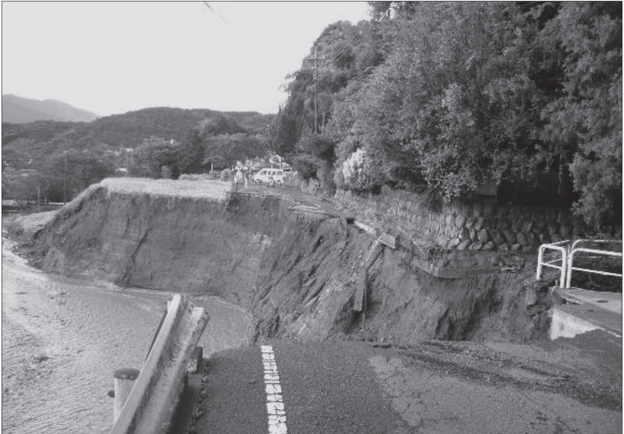
台風第 9 号による町道足柄三保線及び野沢川の被災状況 (柳島地区)「静岡県撮影」
