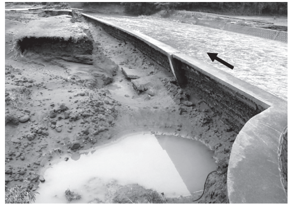
写真-2 護岸背面浸食状況
