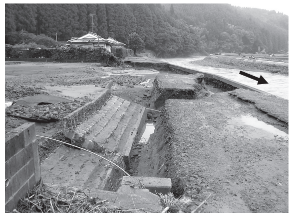
写真-3 護岸背面浸食状況
