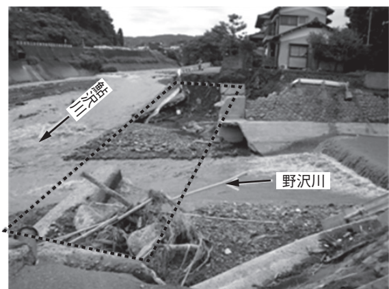
写真－3 町道1001号線 下野沢橋
