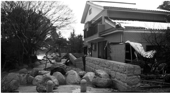
写真－6 水津地区海岸の住家被害
