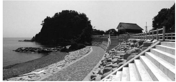
写真-12 改良された防潮堤と突堤C (8tかんらん岩被覆)
