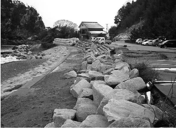
写真-11 被災した緩傾斜護岸と突堤C
