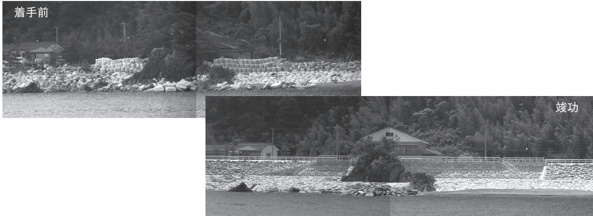
写真-13 防潮堤施工区間の着手前と竣工
