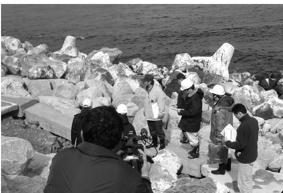
写真-10 総括災害査定官による現地査定
