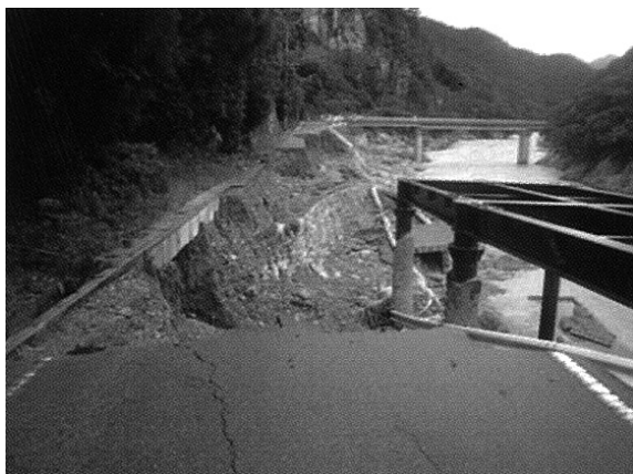
大台町（旧宮川村）の被災状況
