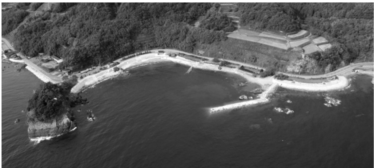
写真-14 水津地区海岸の完成状況
