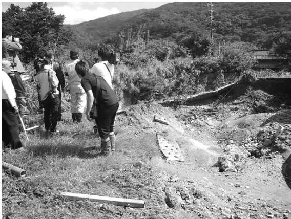
写真－3 二級河川 住用川支川冷川 (奄美市住用町西仲間地先)
