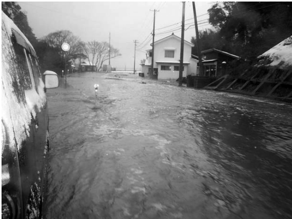
写真－7 越波により冠水した主要地方道佐渡一周線 (写真－4の右手奥)
