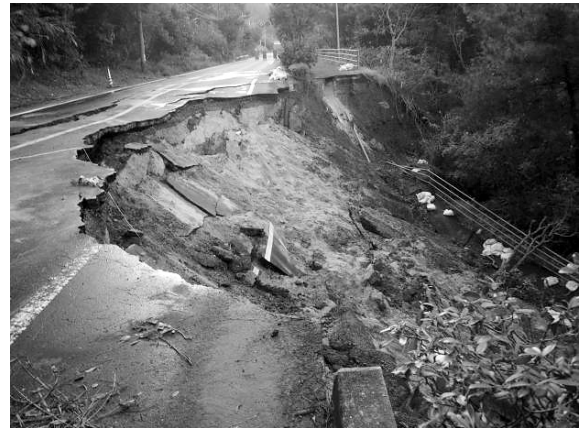
写真－6 国道58号 (奄美市名瀬浦上地内)
