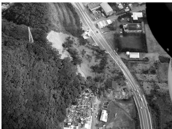
写真－1 国道58号（龍郷町浦付近）
