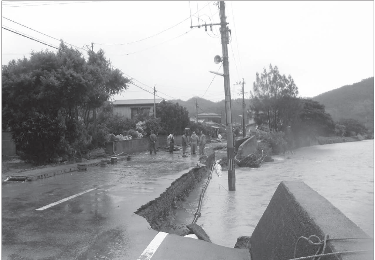
10月20日 奄美地方における豪雨被害 戸口川（鹿児島県龍郷町戸口地内） 撮影者：鹿児島県
