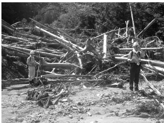
斜面・溪流の危険度調査の様子（広島県庄原市川北町）
