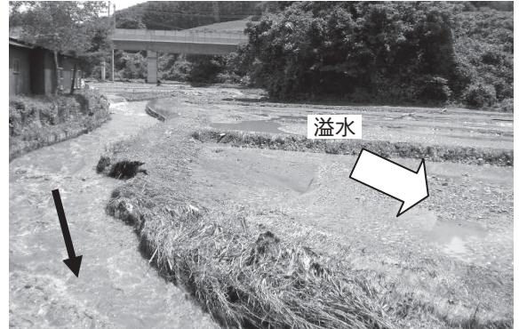
写真－3 溢水氾濫状況
