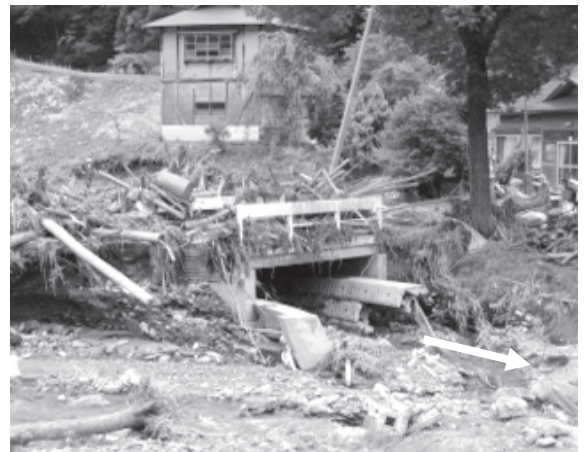
写真－5 橋梁被災状況
