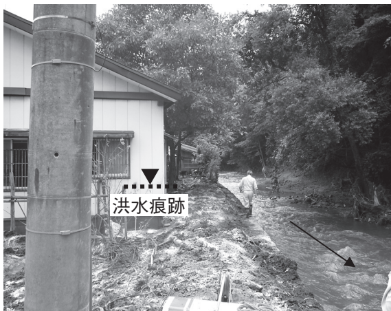
写真-1 家屋浸水状況
