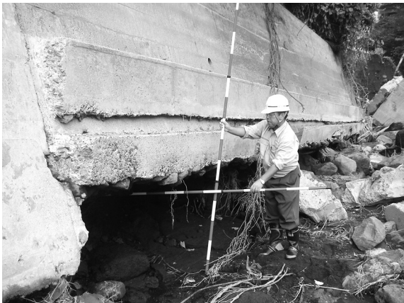
被災状況調査の様子（静岡県駿東郡小山町）
