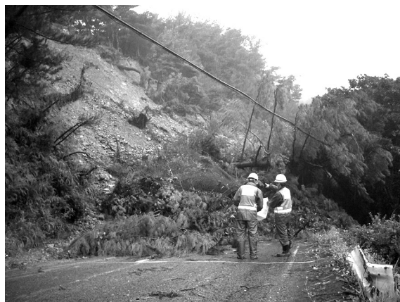
被災状況調査の様子（鹿児島県奄美大島）
