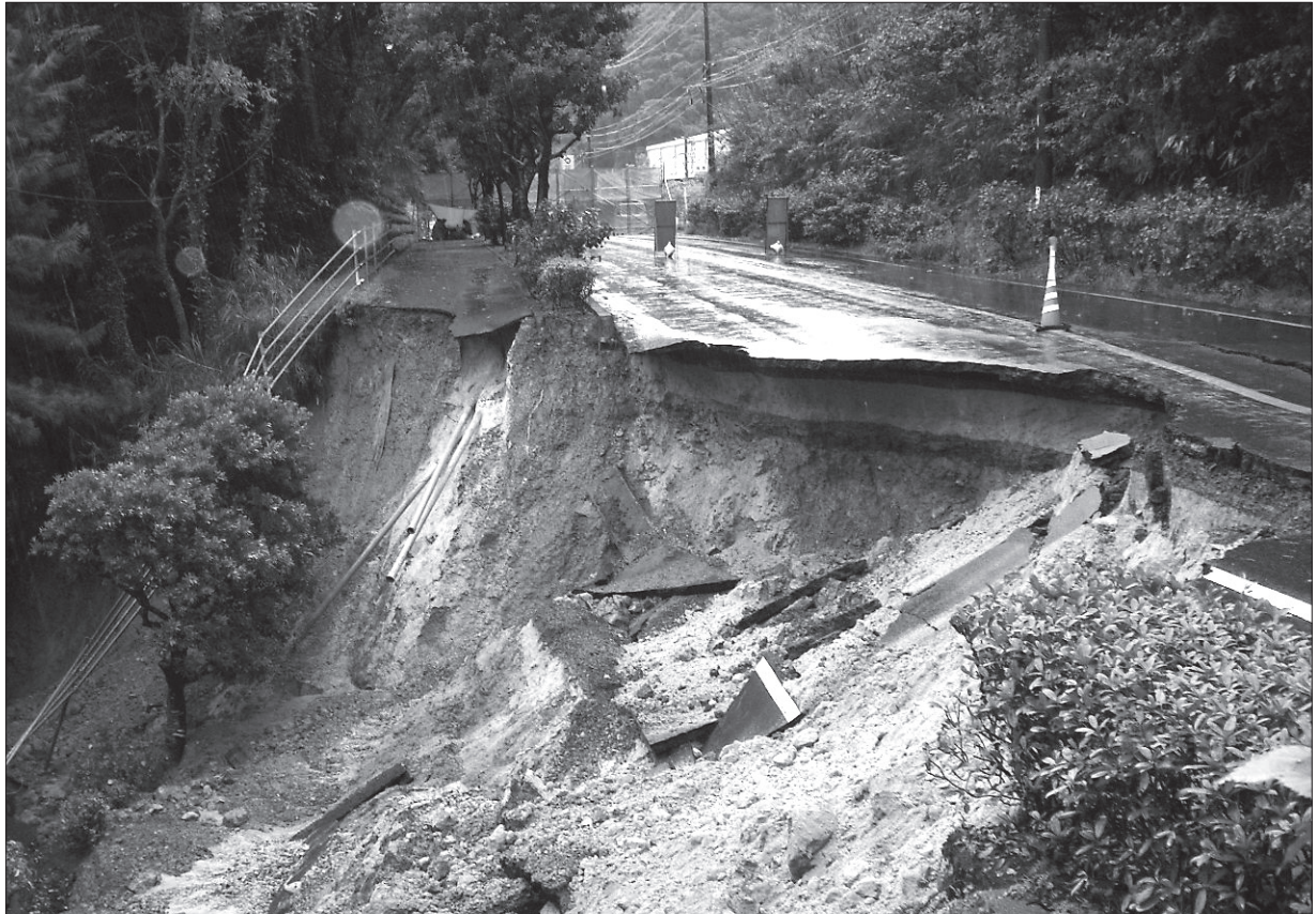
10月20日 奄美地方における豪雨被害 国道58号(奄美市名瀬浦上町) 撮影者：鹿児島県
