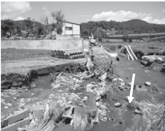
写真－4 護岸被災状況
