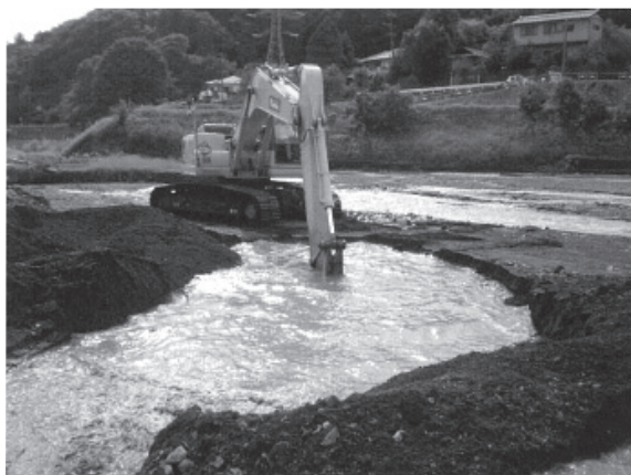
写真－1 野沢川 護岸埋塞箇所の掘削状況
