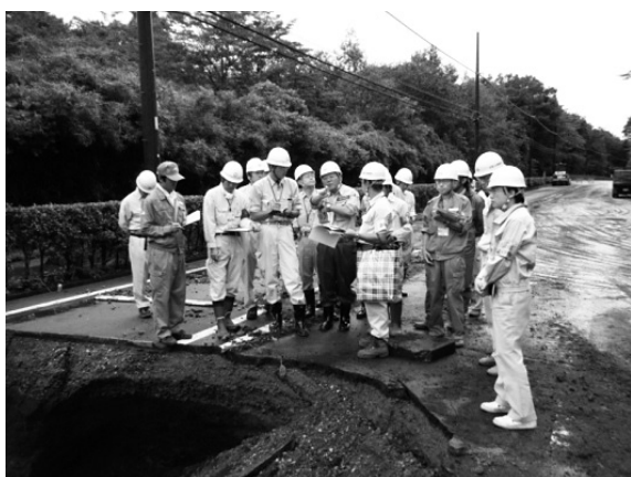
静岡県小山町災害緊急調査 (H22. 9. 15~16)
