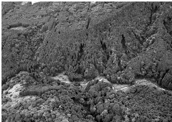
上流域の山腹崩壊の状況
