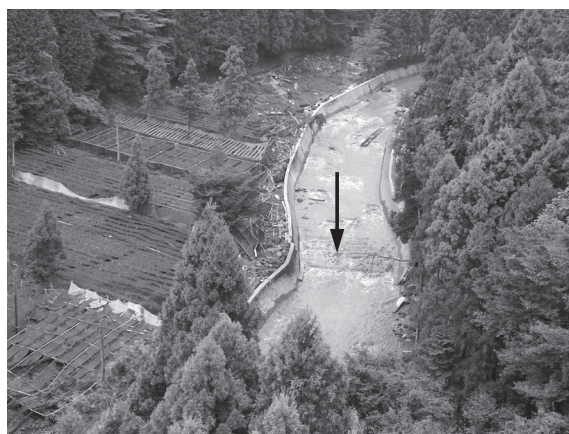
写真－3 須川 溢水によるワサビ田への被害
