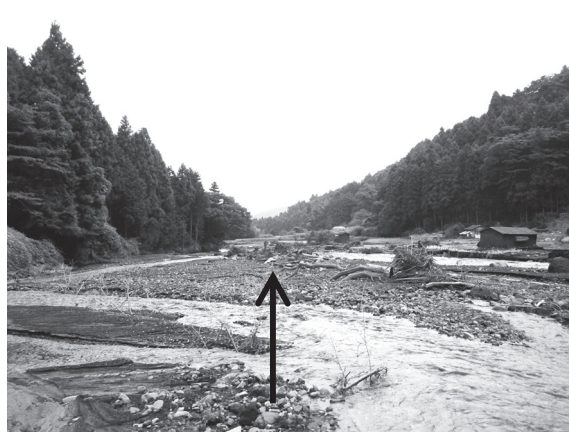
写真④ (二)須川 河川の異常埋塞 (河川及び周辺が埋塞し、平地と化した状態)
