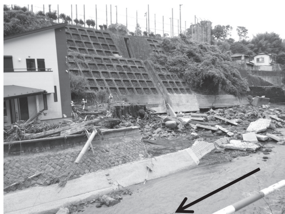
写真① (二)野沢川 護岸崩壊と家屋被害 (洪水が家屋を約10m下流へ押し流す)
