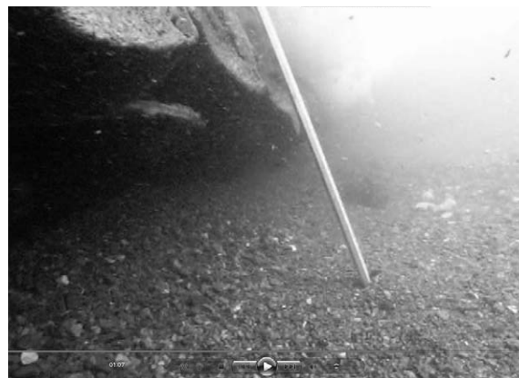
水中ビデオ撮影による基礎部の洗掘状況説明事例
