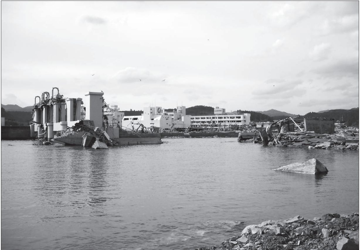
東北地方太平洋沖地震被災状況 南三陸町 (写真提供：宮城県)
