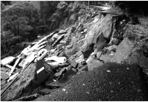
鹿児島県霧島市 主要地方道都城隼人線の被災状況
