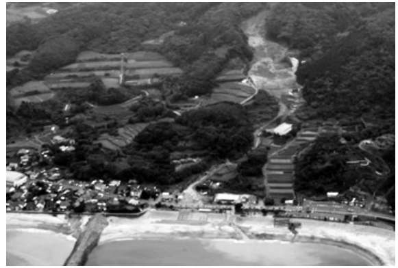
鹿児島県大隅町の土石流
