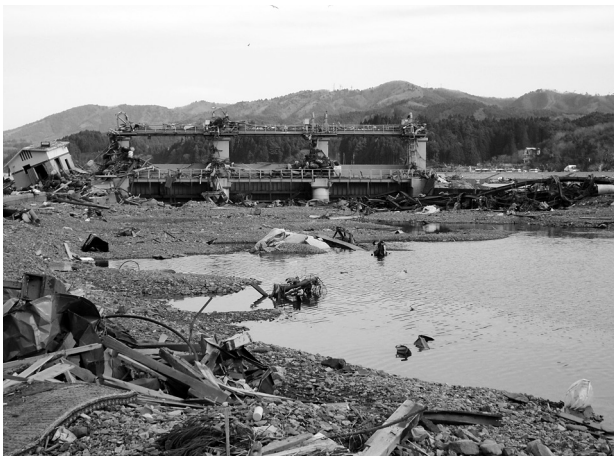
折立川防潮水門（南三陸町）
