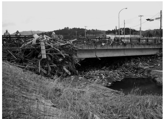
坂元川国道6号橋（山元町）
