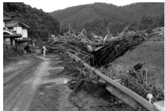
広島県庄原市 県道中迫川北線の被災状況
