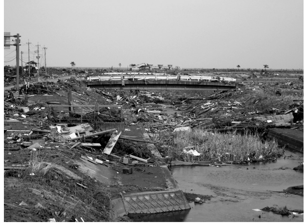
坂元川国道6号線より下流（山元町）
